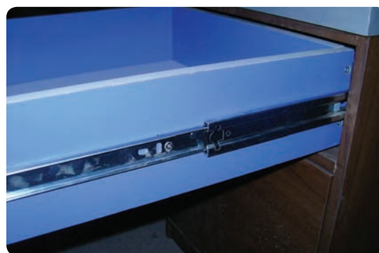
شکل ۶-۵۷ ریل مکانیکی دو مرحله‌ای
