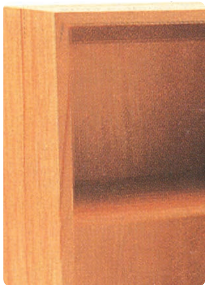
شکل ۶-۷ سقف و کف همرو با بدنه
