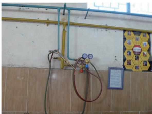
در تصویر زیر میز و الحاقی‌های لازم برای جوشکاری گاز که توسط خود جوشکار برای سهولت عملیات جوشکاری ساخته شده و در آن مشعل گیر و جایی برای پودر کاربید ایجاد شده است، ملاحظه می‌کنید.
