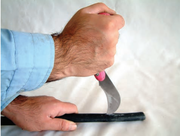
الف - نحوه‌ی غلط لخت کردن کابل
