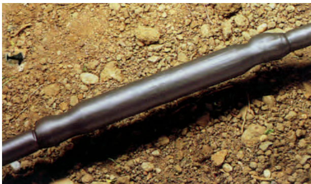
ج- وضعیت روکش پس از عملیات
