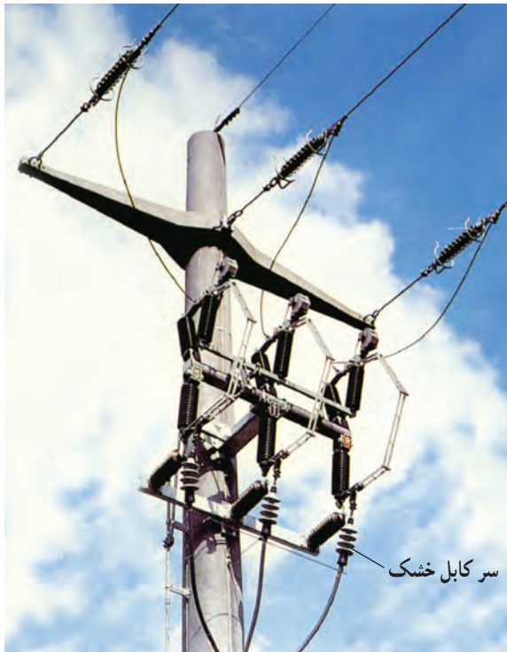
شکل ۶-۶- سر کابل خشک حرارتی هوایی
