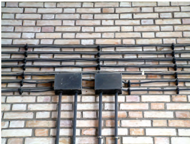
شکل ۵-۵۷- کابل‌کشی روی دیوار
