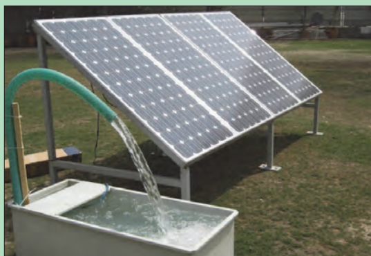
شکل ۳۸- کاربرد سامانه فتوولتاییک در پمپ چاه آب
