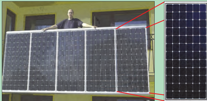
شکل ۲۸- یک پنل خورشیدی با پنج مدول سری شده
