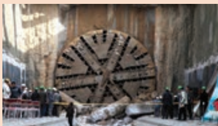
لحظه رسیدن دستگاه T.B.M خط ۲ مترو مشهد به ایستگاه ۴ (چهارراه گاز)
