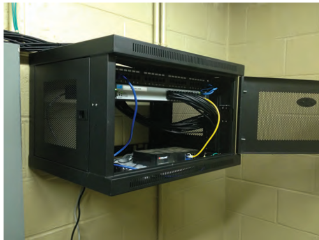
شکل ۴-۱۴ - نمونه‌ای از رک دیواری
