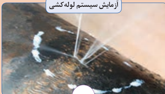
آزمایش سیستم لوله کشی
