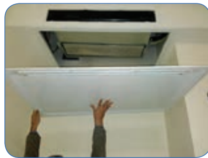
شکل ۱۴- نمونه دریچه دسترسی و برگشت هوا
