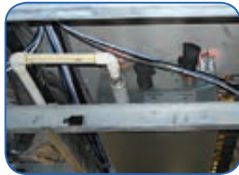
شکل ۸- نمونه اتصال لوله تخلیه به تشتک
