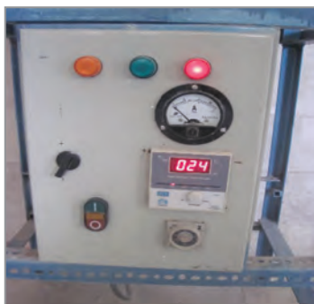
شکل ۳۵- اندازه‌گیری دمای کوره
