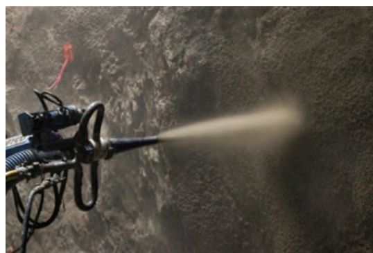
شکل ۲۸- نصب جرم با روش پاشش
