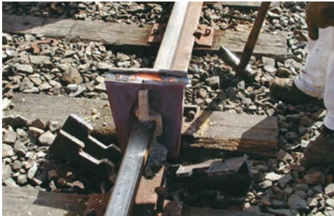
شکل ۲۵- باز کردن گیره و حفاظ قالب
