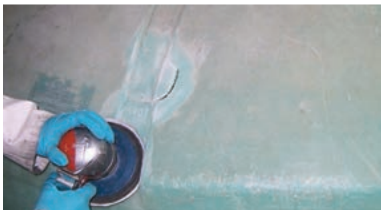
شکل ۲۷- آماده‌سازی سطوح پلاستیکی قبل از جوشکاری
