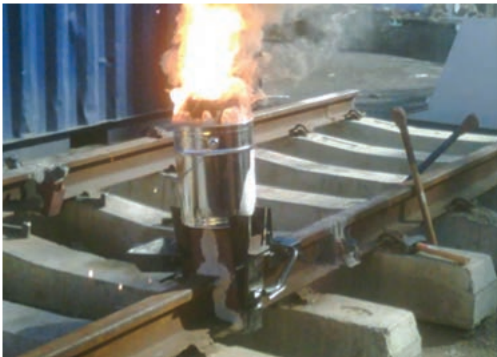
شکل ۲۳- نمایی از انجام واکنش ترمیت
