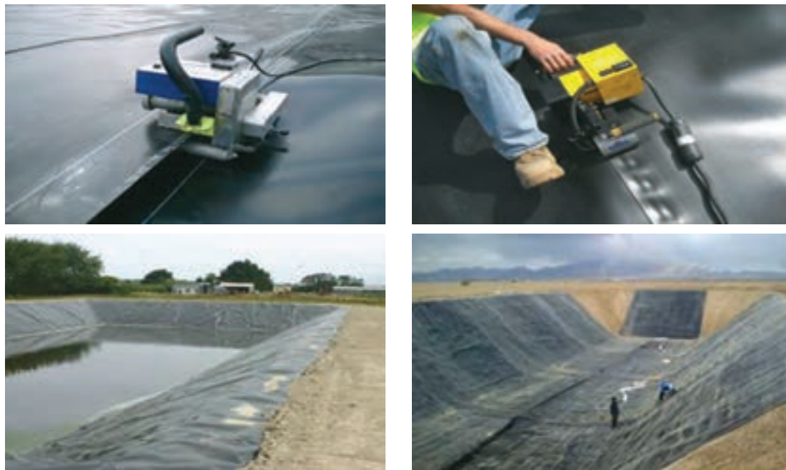
شکل ۱۵- جوشکاری عایق‌های پلاستیکی (ژئوممبران) استخرهای ذخیره آب
