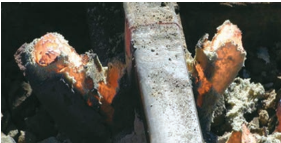
شکل ۲۷- برش گرده اضافی جوش
