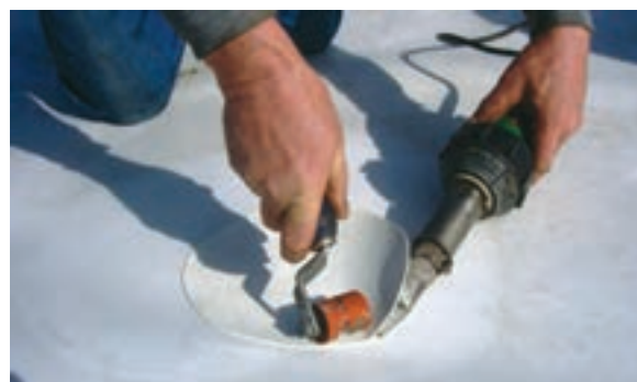
شکل ۱۲- جوشکاری با گاز داغ به صورت دستی
