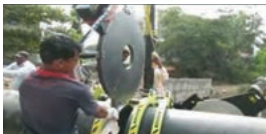
شکل ۱۹- جوشکاری لب به لب Butt Fusion
