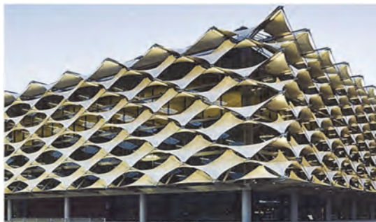
شکل ۲۰- یک عدد پارکینگ با سقف پارچه‌ای و یک عدد نمای پارچه‌ای در ساختمان
