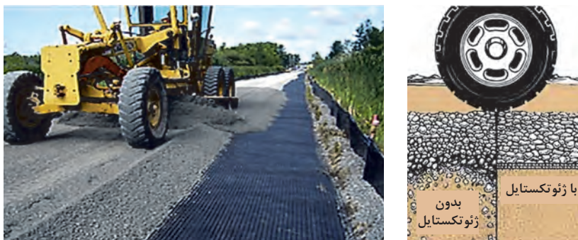
شکل ۲۵- کاربرد پارچه‌های ژئوتکستایل در زیرسازی راه
