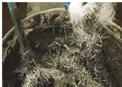
شکل ۱۸- استفاده از الیاف شیشه در مخلوط سیمان
