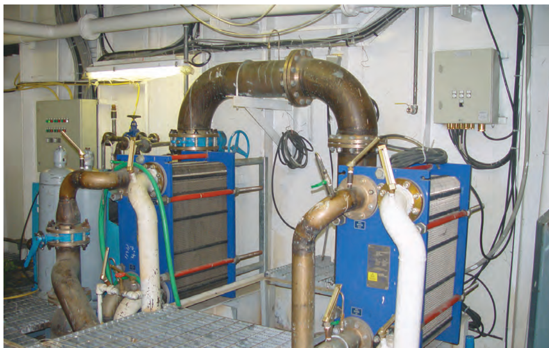
شکل ۶- سامانه خنک کاری آب دریا
