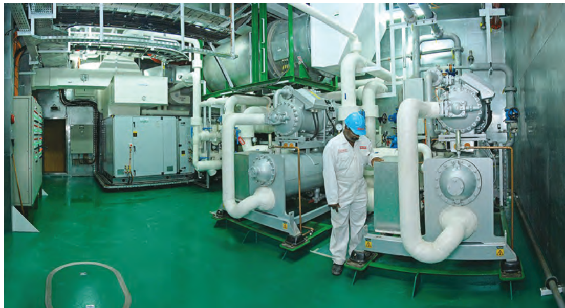
شکل ۲- نمونه‌ای از سامانه تهویه مطبوع در شناور
