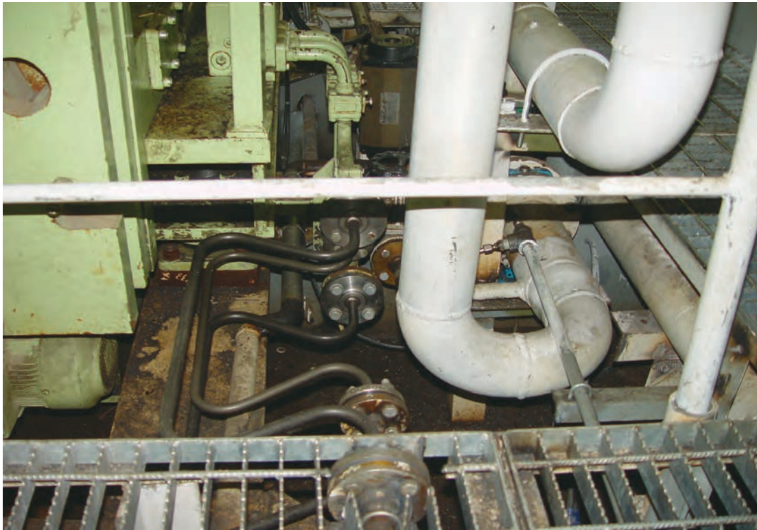
شکل ۲۴- سامانه سوخت رسانی
