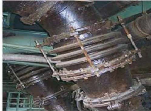
شکل ۴۳- اتصال‌های قابل انبساط
