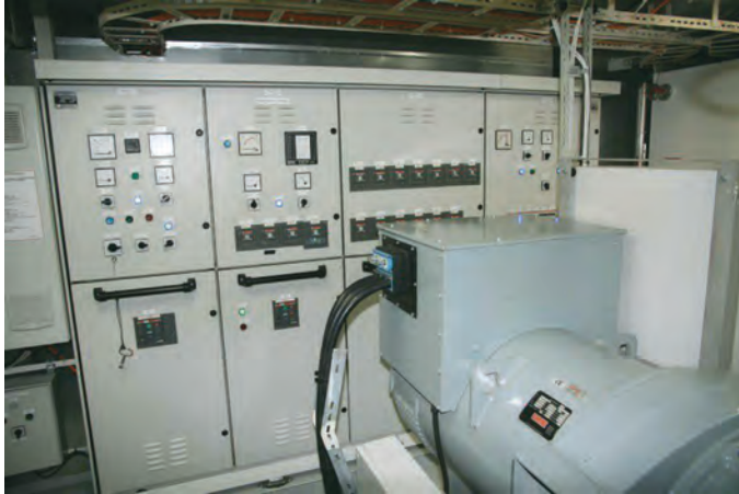
شکل ۷- تولید و توزیع برق شناور
