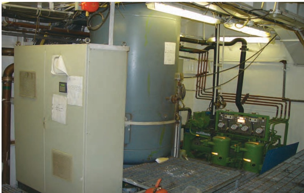
شکل ۱۷- سامانه هوای فشرده
