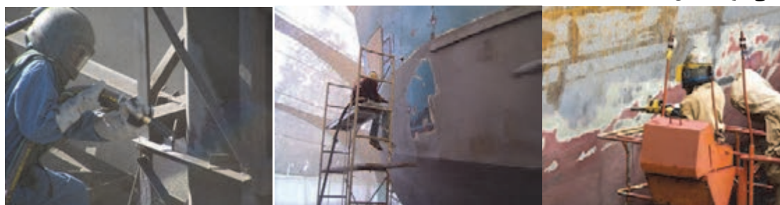
شکل ۱-۷ زنگ‌زدایی در اسکله خشک
