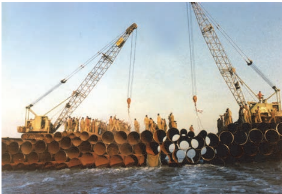
شکل ۱۱-۵- پل بعثت در حال ساخت
