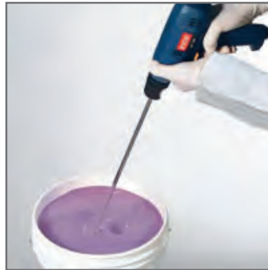
۱ مخلوط کردن لعاب با استفاده از همزن
