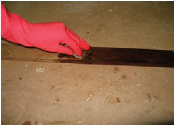
شکل ۶۵-۱۳- آسترکاری چوب راش.
