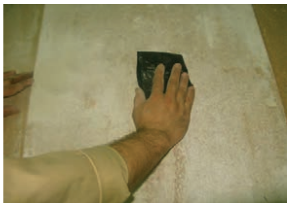
شکل ۴۹-۶- سنباده‌کاری روی سطح بتونه سریشی.
