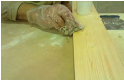
شکل ۱۲-۶- سطح کار قبل از بتونه هم‌رنگی آب زده شود.
