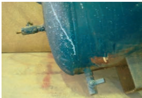
شکل ۷-۷- شیر تفلیه آب و روغن اضافی در زیر مخزن کمپرسور.
