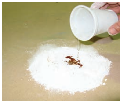
شکل ۲۳-۶- اضافه نمودن آب به بتونه روغنی.
