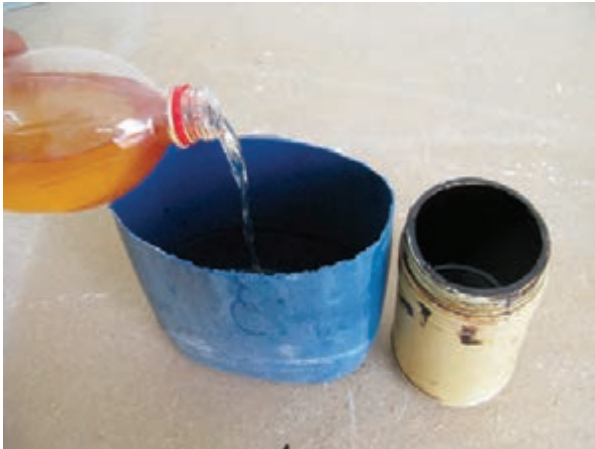
شکل ۴۴-۱۲- رقیق کردن آستری قیری با بنزین.
