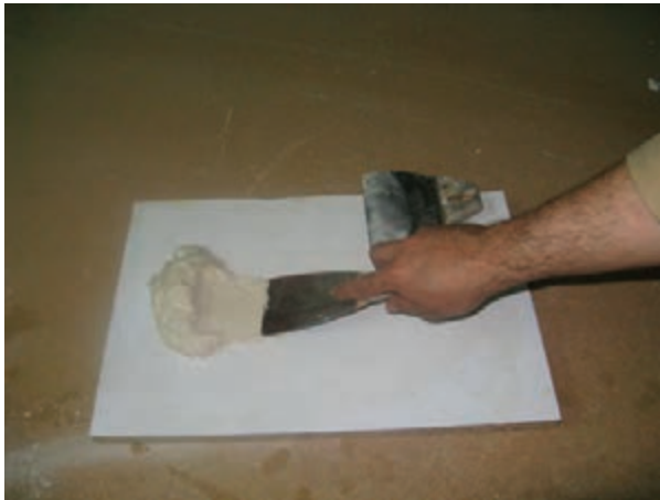
شکل ۱۸-۱۱- ماستیک‌کاری سطح کار.
