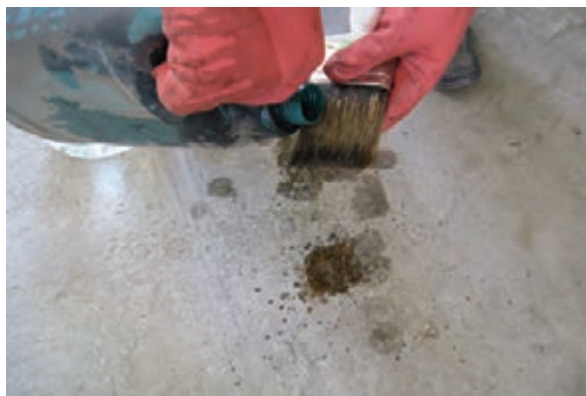
شکل ۱۰-۱۳- شستن قلم‌مو با ملال به روش ناصمیح.
