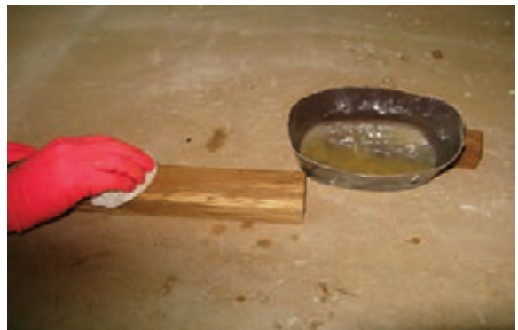
شکل ۳۸-۱۳- سیلرکاری با کهنه رنگ‌کاری.
