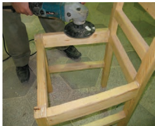
شکل ۳۷-۶- پرداخت کاری قبل از بتونه.
