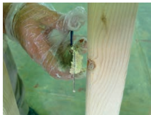
شکل ۷-۶- کاربرد بتونه سریشمی در سوراخ‌ها و شکاف‌های بزرگ.
