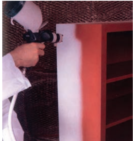
شکل ۱۱-۱۰- استفاده از پیستوله برای پاشیدن رنگ فوری به روی سطح کار.
