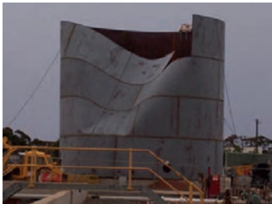
شکل ۴-۲۷- آسیب دیدن مخزن به دلیل وزش باد
