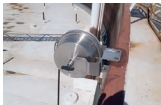
شکل ۴-۲۶- تخلیه الکتریسیته ساکن در مخزن سقف شناور
