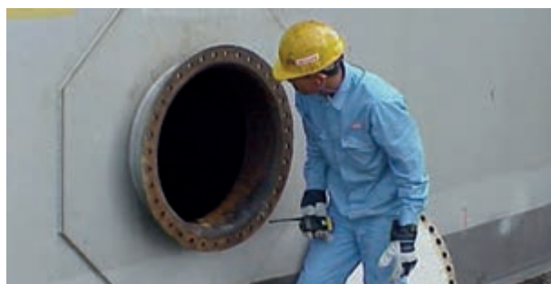
شکل ۲۱-۴- دریچه آدم‌رو مخزن
