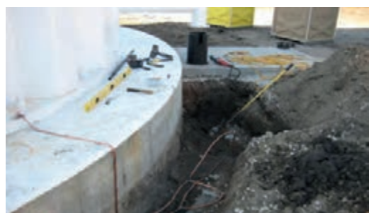
شکل ۴-۲۵- تخلیه الکتریسیته ساکن بدنه مخزن به زمین
