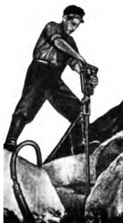
شکل ۴-۱۳- وضعیت ناپایدار کارگر کوه‌بُر بر روی گرانیت (۶)
