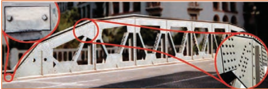
شکل ۳- اتصال دائم : پرچ
