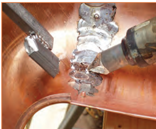
ب - لحیم کاری دو قطعه مسی
