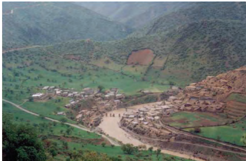
شکل ۳۸-۱- عدم رعایت حریم رودخانه و خطر سیل
