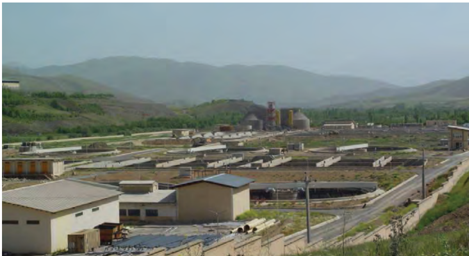
شکل ۷۳-۱- تصفیه‌خانه فاضلاب سنندج
