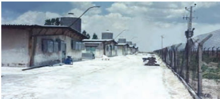
شکل ۱- حصارکشی اطراف سالن‌های مرغداری
