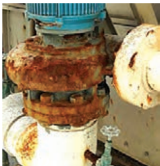
شکل ۵-۵۰- خوردگی الکتروشیمیایی قطعات فلزی
