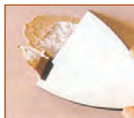
الف - باز کردن ترک‌ها
