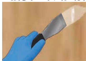
۴- صاف کردن هرگونه ترک از روی دیوار
