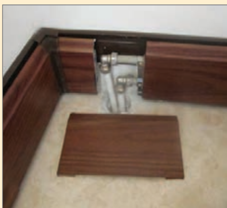
اتصال لوله کشی رادیاتور قرنیزی با کاور نهایی
