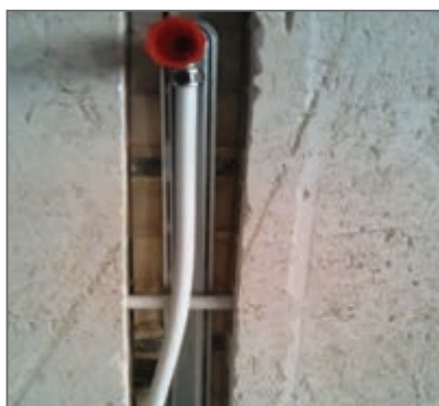
اتصال لوله به دیوار
