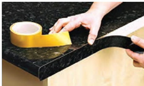
شکل ۱۱۹ - نصب نوار لبه صفحه تاپس
