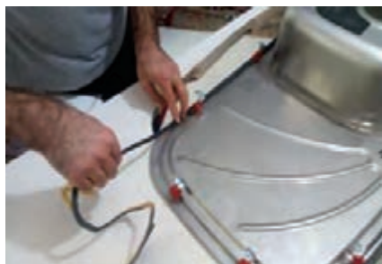
شکل ۱۰۴- نصب نوار آب بندی پشت لبه سینک
