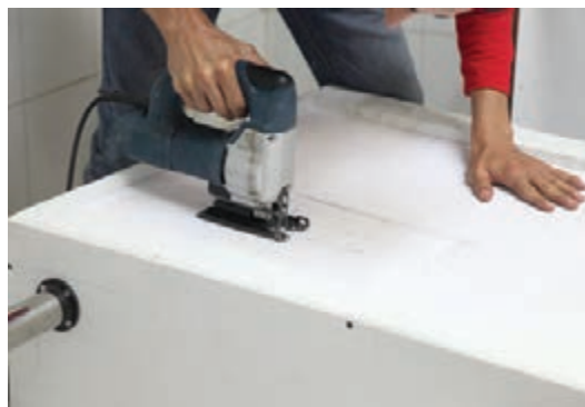
شکل ۱۲- نحوه درآوردن جای لوله‌های تأسیسات و پریز برق با اره چکشی
