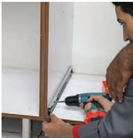
شکل ۸۲ - نصب قطعه یک تکه روی بدنه‌ها
