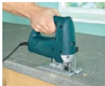
شکل ۱۰۱- برش کاری محل قرارگیری سینک
