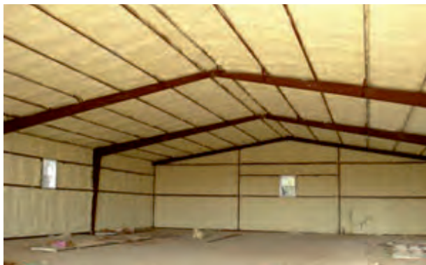
عایق‌بندی سقف و دیواره
