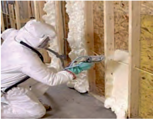
عایق‌بندی با نوعی فوم خمیری
