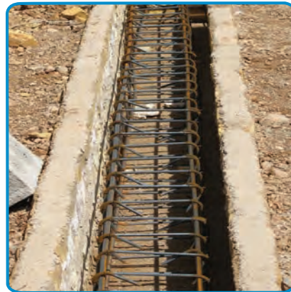
شکل ۵-۷- اجرای میلگرد شناژها
