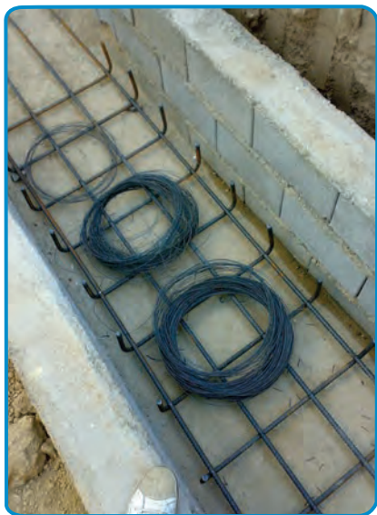
شکل ۹-۷- به هم بستن میلگردها
