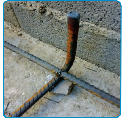
شکل ۳-۷- خم میلگرد در کنار و به هم بستن میلگردهای طولی و عرضی
