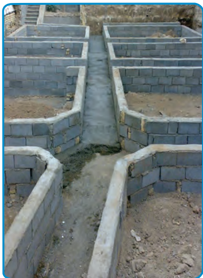
شکل ۶-۷- آماده سازی کف پی
