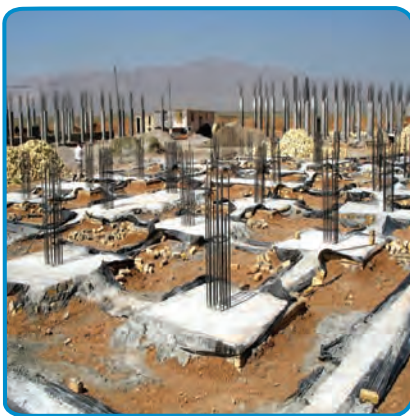
شکل ۱۷-۷- اجرای خاموت و سنجاقک
