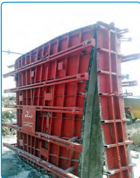
شکل ۳-۴۲- قالب برداری
