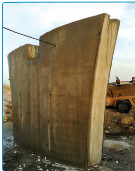
شکل ۳-۴۲- قالب برداری
