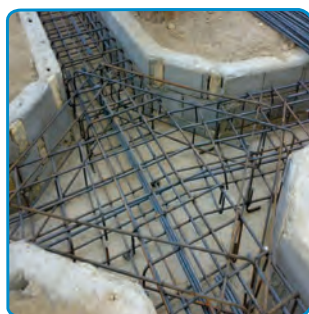
شکل ۱۴-۷- تکمیل میلگردگذاری محل اتصال ستون
