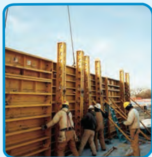
شکل ۳-۳۶- قالب فایبر گلاس برای اجرای دیوار بتنی
