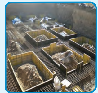
شکل ۳-۳۱- قالب فایبرگلاس برای اجرای پی
