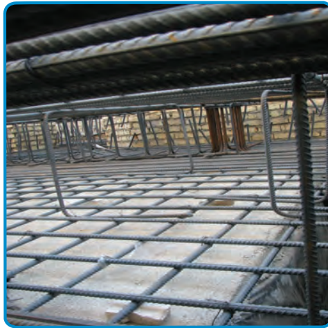
شکل ۳-۵۳- استفاده از خرک در میلگرد گذاری پی
