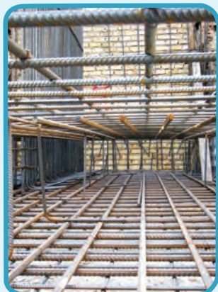
شکل ۱۵-۱- فولاد در بتن
