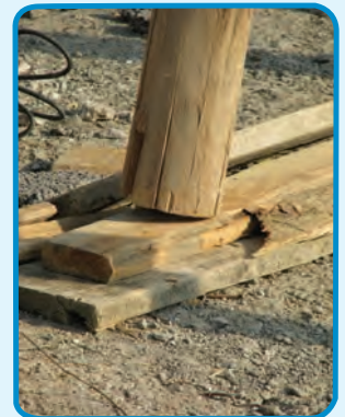
شکل ۳-۲۵- استفاده از گوه جهت تنظیم ارتفاع
