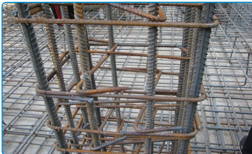
شکل ۵۰-۳- کاربرد سنجاقک در میلگرد گذاری ستون
