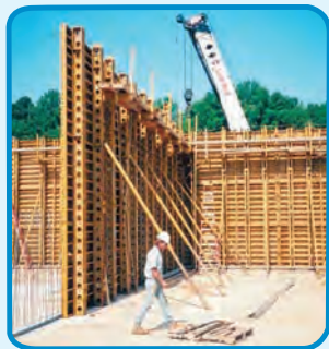
شکل ۱۹-۳- اجرای دیوار بتنی فایبر گلاس برای
