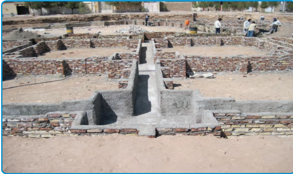
شکل ۳-۲۹- قالب آجری برای اجرای پی
