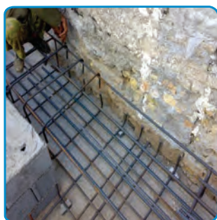
شکل ۱۲-۷- میلگردگذاری شبکه بالای
