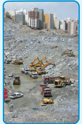
شکل ۳-۷- گودبرداری در زمین‌های نامحدود
