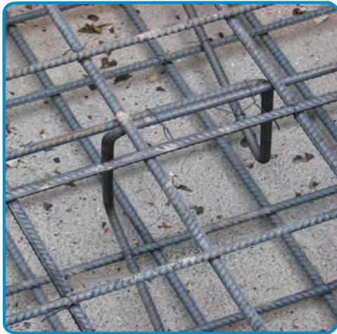
شکل ۳-۵۳- استفاده از خرک در میلگرد گذاری پی
