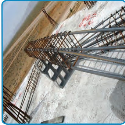
شکل ۷-۲۲- آماده کردن میلگردهای تیر روی زمین
