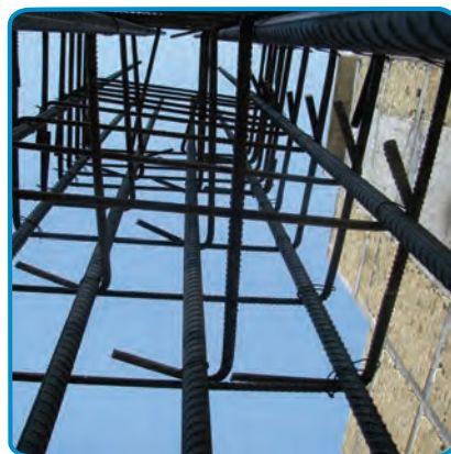
شکل ۱۹-۷- کار گذاشتن میلگردهای انتظار ستون، در فونداسیون
