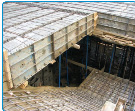
شکل ۴۰-۷- اجرای میلگردهای دال پله
