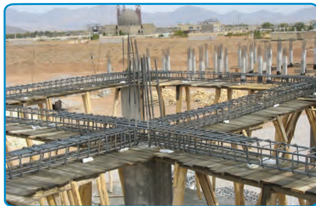
شکل ۷-۲۷- رعایت فاصله پوشش بتنی در کف
