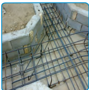
شکل ۱۳-۷- قرار دادن میلگردهای تقویتی پخها
