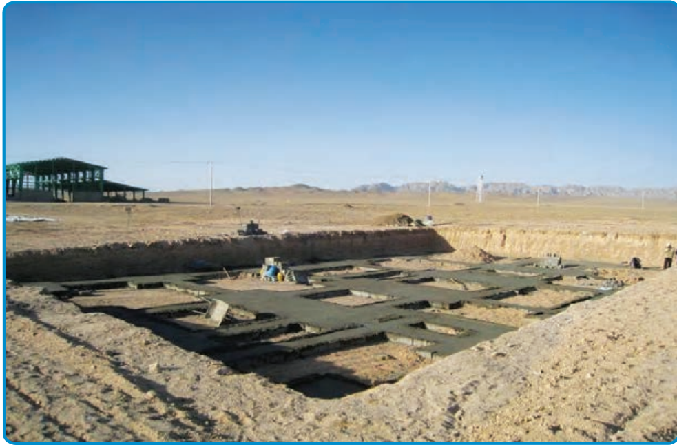
شکل ۳-۶- گودبرداری در زمین‌های نامحدود
