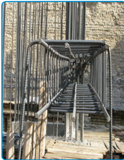
شکل ۳-۴۵- میلگرد طولی در تیر
