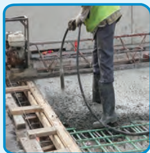
شکل ۱۴-۳- وایبراتور یا لرزاننده بتن داخل قالب
