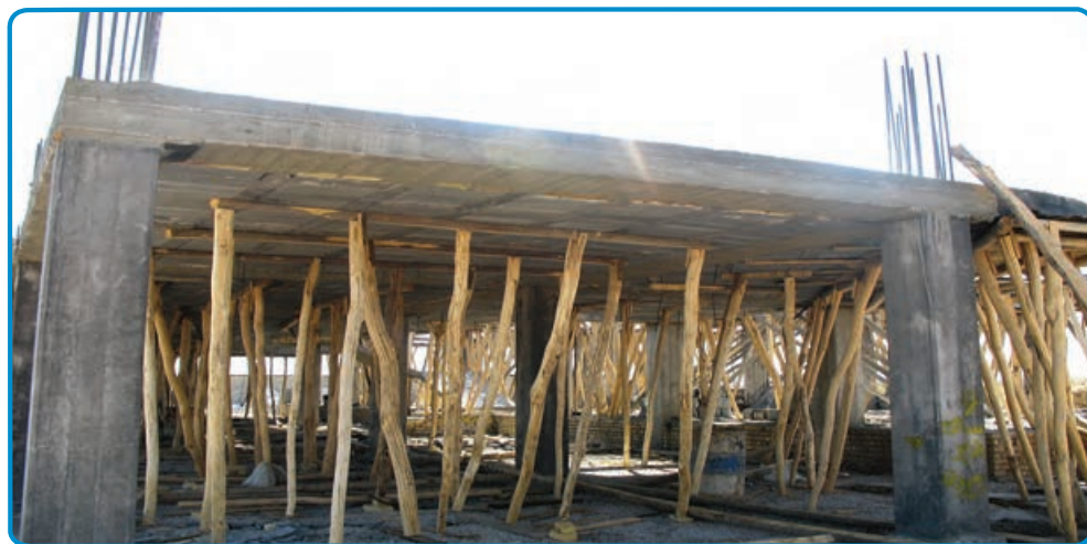
شکل ۴۳-۳- استفاده از پایه‌های اطمینان پس از قالب‌برداری سقف
