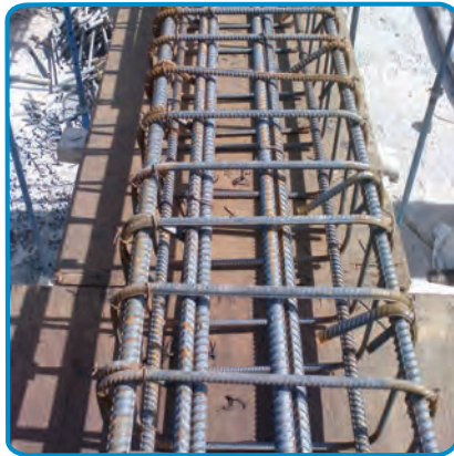
شکل ۷-۲۵- بستن خاموت ها با مفتول
