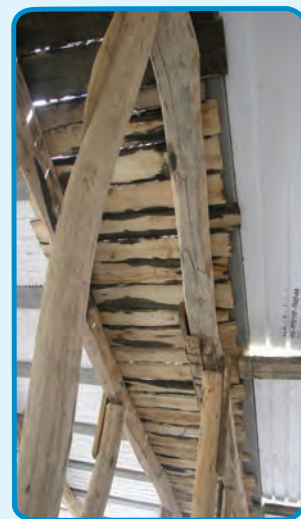
شکل ۱۶-۳- استفاده از قالب چوبی برای اجرای تیر بتنی
