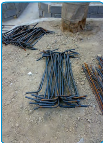
شکل ۷-۷- آماده کردن میلگردهای طولی و عرضی
