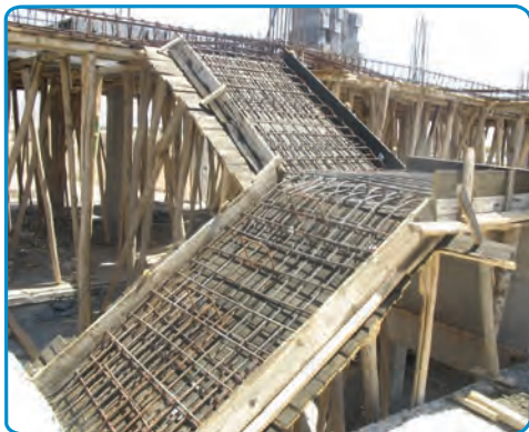
شکل ۳۹-۷- اجرای میلگردهای دال پله
