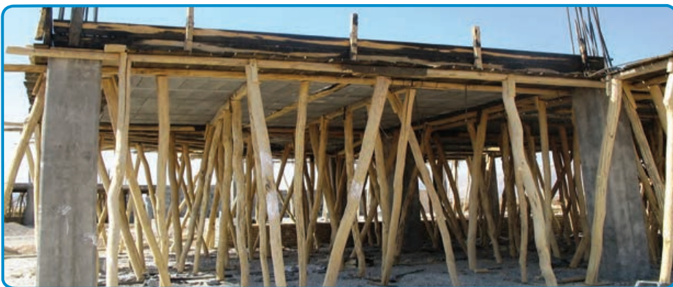
شکل ۳-۲۴- استفاده از شمع‌های چوبی جهت نگهداری قالب‌ها
