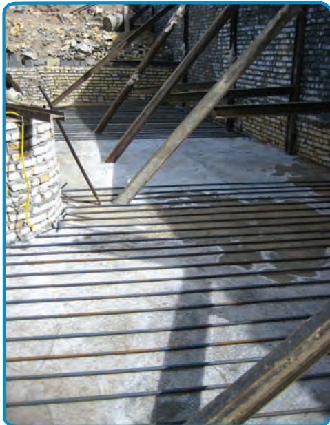
شکل ۳-۴۶- میلگرد طولی کف پی
