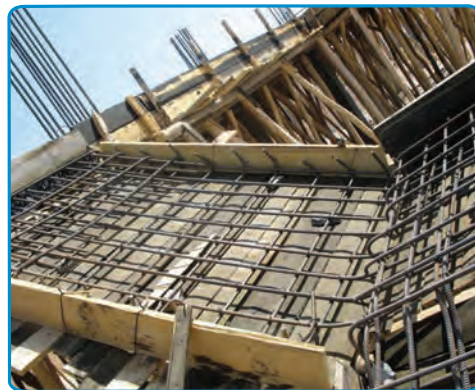
شکل ۳۸-۷- اجرای میلگردهای دال پله
