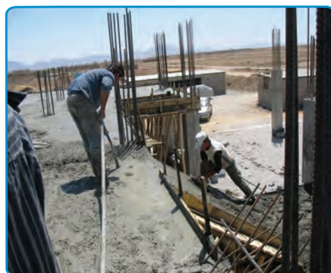
شکل ۴۲-۷- بتن ریزی دال پله
