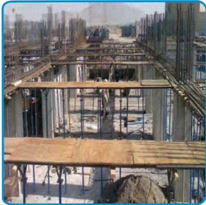
شکل ۷-۲۱- قالب بندی تیرها
