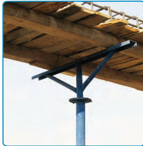
شکل ۳-۲۱- استفاده از شمع‌های فلزی جهت نگهداری قالب‌ها
