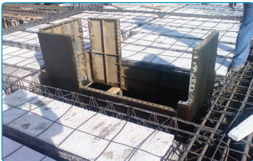
شکل ۳۵-۷- تکمیل قالب بندی
