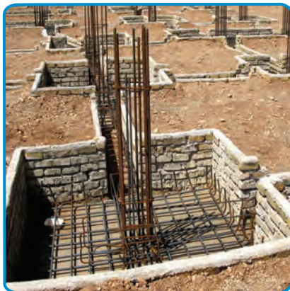
شکل ۴-۷- اجرای میلگردهای ریشه انتظار
