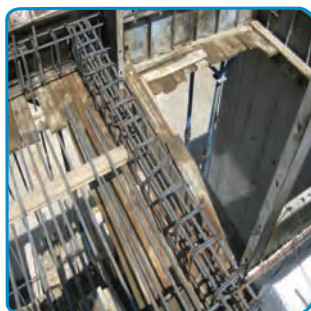
شکل ۳۱-۷-اجرای بازشودر سقف
