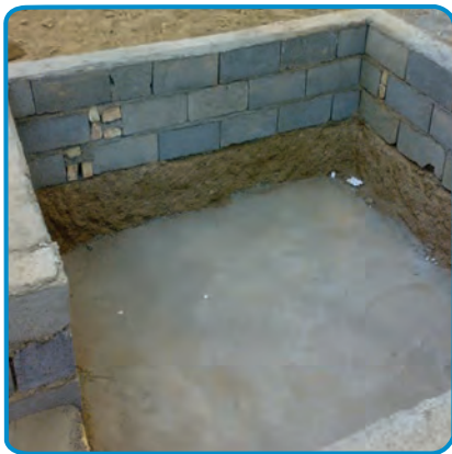
شکل ۱-۷- آماده سازی کف پی
