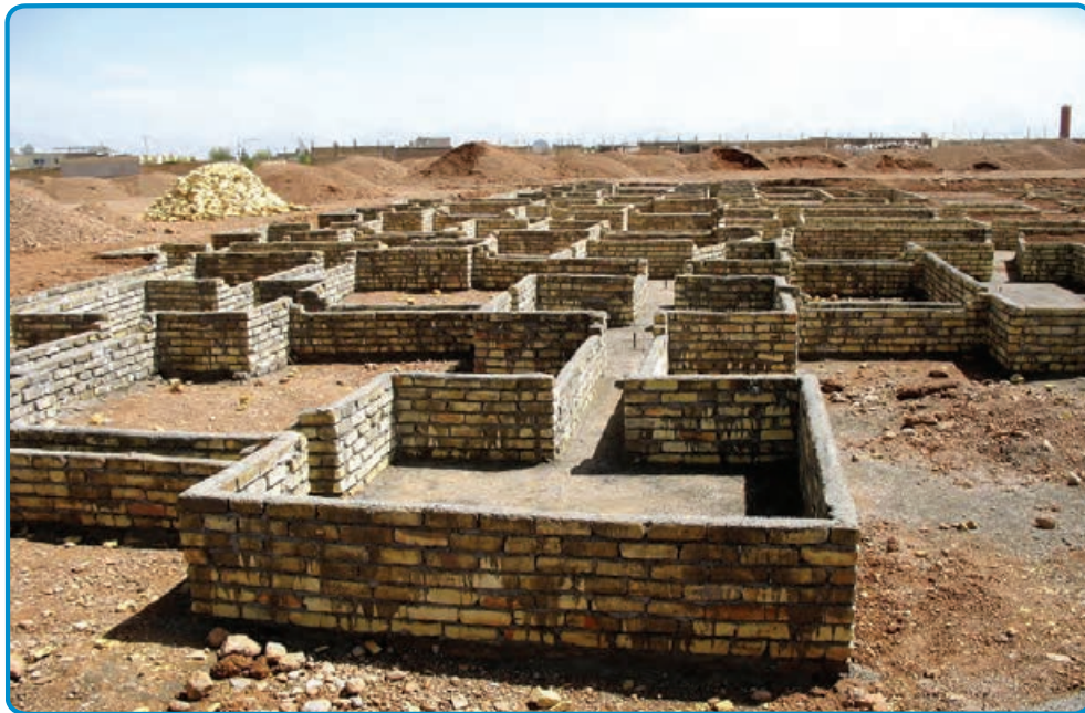
شکل ۱۵-۳- استفاده از قالب آجری برای اجرای پی
