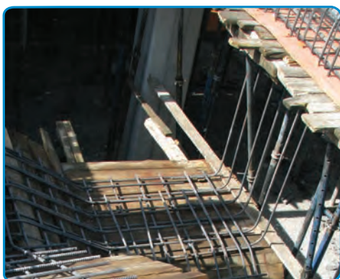
شکل ۴۱-۷- اجرای میلگردهای دال پله
