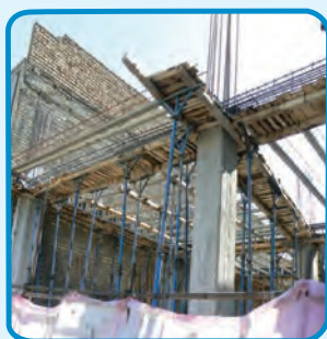
شکل ۳-۳۹- استفاده از قالب چوبی برای اجرای تیر
