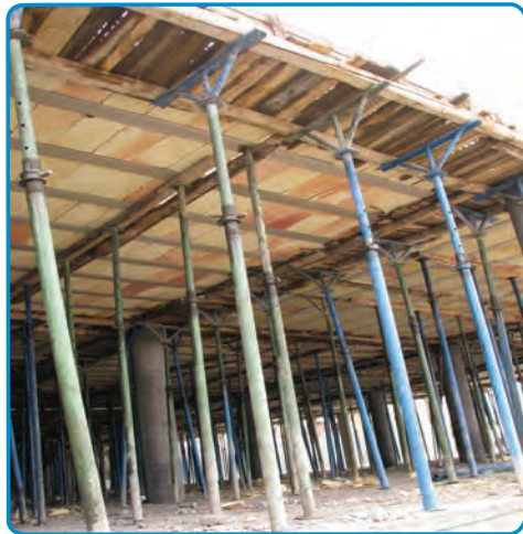
شکل ۳-۲۱- استفاده از شمع‌های فلزی جهت نگهداری قالب‌ها
