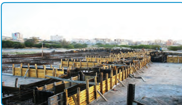
شکل ۳-۲۷- قالب چوبی برای اجرای پی
