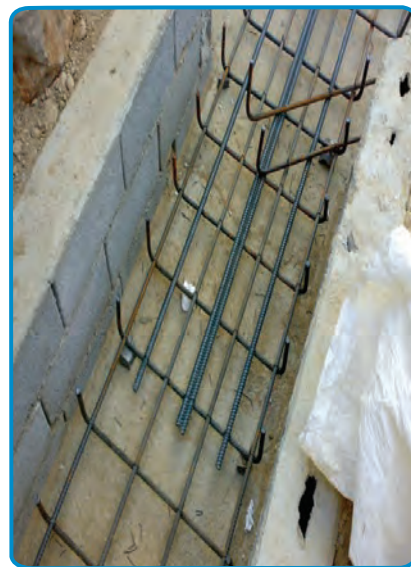
شکل ۱۱-۷- قرار دادن میلگردهای تقویتی
