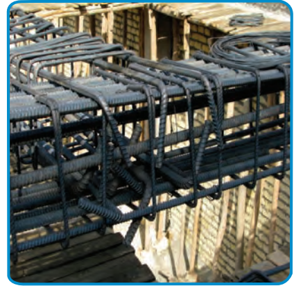
شکل ۷-۲۶- خم میلگردهای اصلی در انتهای محل قرار گیری
