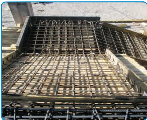
شکل ۳۷-۷- اجرای میلگردهای دال پله
