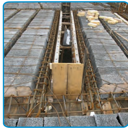
شکل ۳۰-۷-اجرای بازشودر سقف
