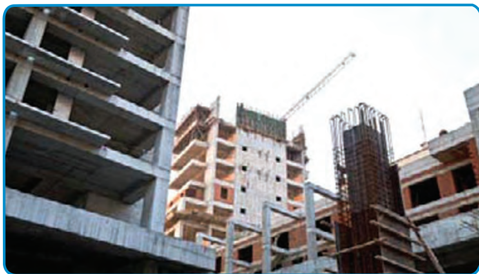
شکل ۱-۲- سازه‌های بتن آرمه
