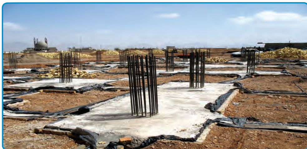
شکل ۱۰-۳- استفاده از پلاستیک در پی
