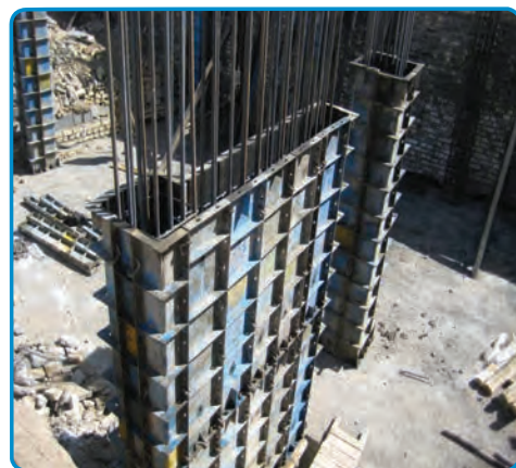
شکل ۳-۳۵- قالب فلزی برای اجرای دیوار بتنی
