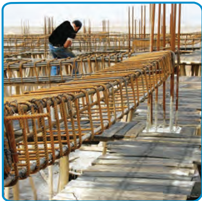
شکل ۷-۲۴- تنظیم فاصله بین خاموت ها
