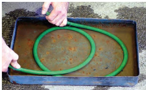
شکل ۲-۹۹ – کنترل نشتی شیلنگ در آب
