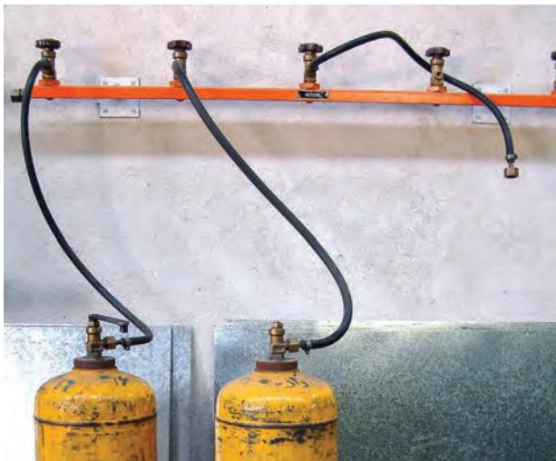
شکل ۲-۲۵- گاز استیلن از کپسول به خط لوله‌ی گاز هدایت می‌شود.
