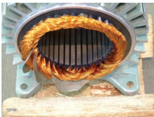
شکل ۲-۳۱- عایق کاری پیشانی کلاف‌ها
