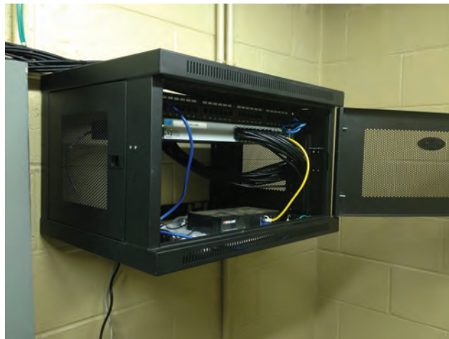
شکل ۴-۱۴ - نمونه‌ای از رک دیواری
