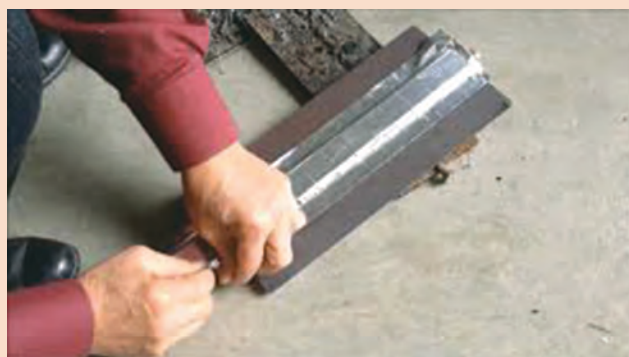
شکل ۱۸- نصب پشت بند سرامیکی
