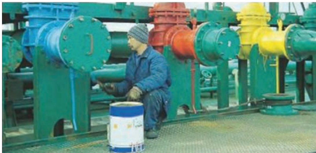
شکل ۵۵- رنگ آمیزی سامانه‌های لوله‌کشی بر روی عرشه
