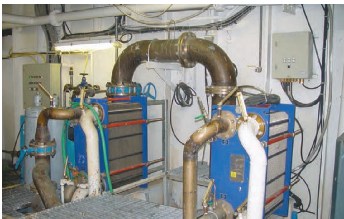
شکل ۶- سامانه خنک کاری آب دریا
