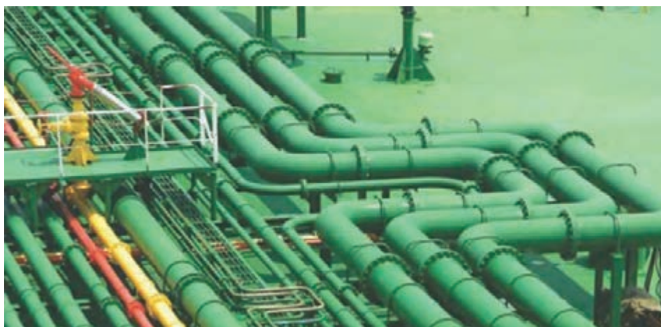
شکل ۲۹- سامانه لوله‌کشی روی عرشه یک نفتکش
