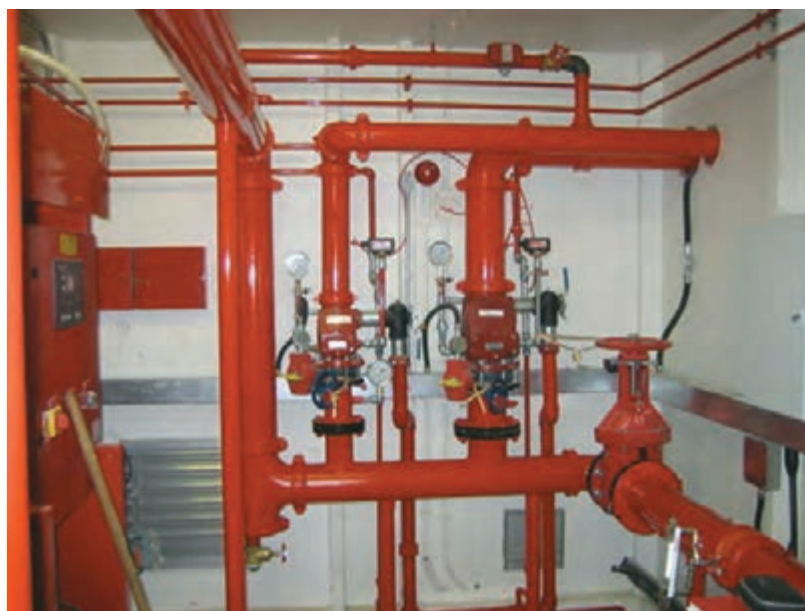
شکل ۱۰- قسمتی از سامانه آتش‌نشانی یک شناور
