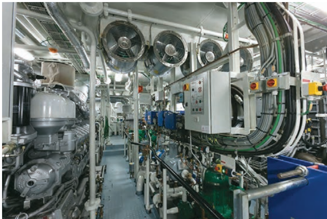
شکل ۱- نمونه‌ای از سامانه تهویه در شناور
