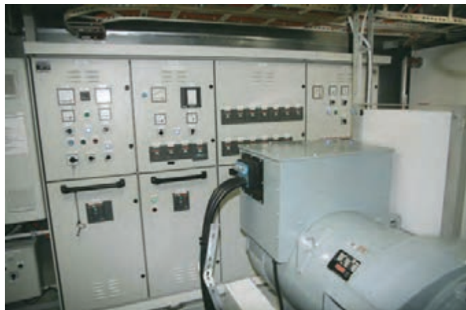
شکل ۷- تولید و توزیع برق شناور
