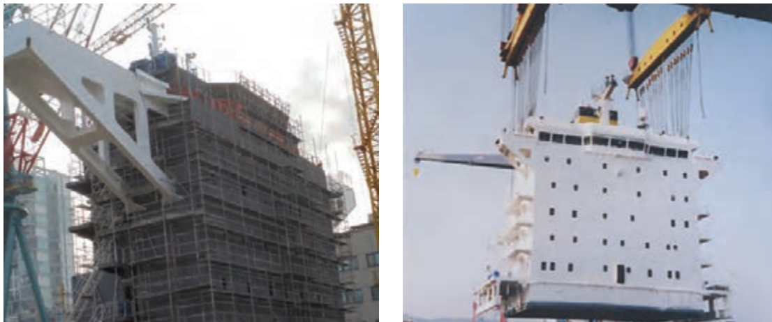
شکل ۱۶- ساختمان محل استراحت خدمه و پل فرماندهی
