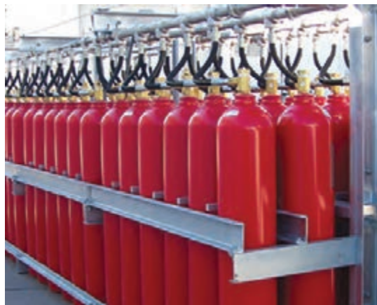
شکل ۳۸- سامانه اطفای حریق CO 2
