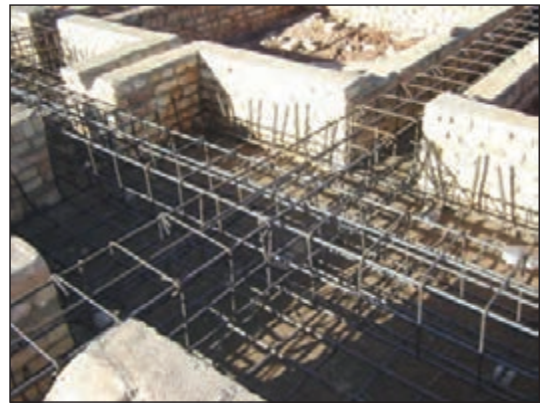
شکل ۳-۱۳۵ عبور میلگردهای شناژ در پی
