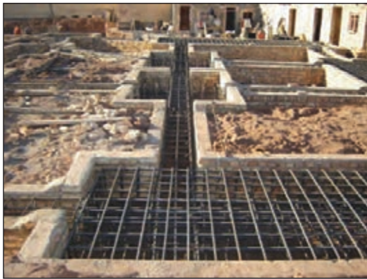
شکل ۳-۱۳۴ میلگردگذاری در پی کلاف بندی
