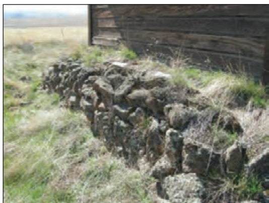
شکل ۳-۴۰ پی سنگی با سنگ لاشه
