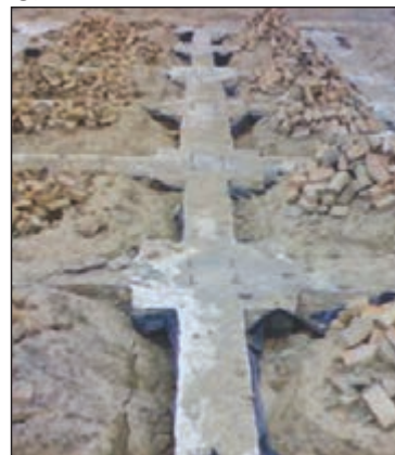
شکل ۳-۱۳۷ پی و شناژ بعد از بتن‌ریزی
