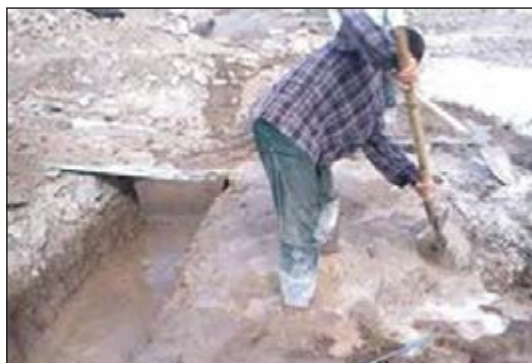
شکل ۳-۳۷ اجرای شفته آهک در فونداسیون
