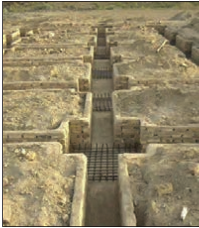
شکل ۳-۵۴ آرماتورگذاری پی تکی کلاف بندی شده
