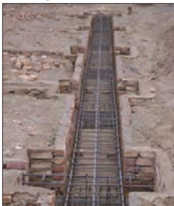
شکل ۳-۱۳۶ پی و شناژ قبل از بتن‌ریزی
