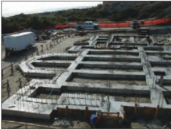
شکل ۳-۶۲ پی بتن مسلح نواری شبکه ای زیرستون
