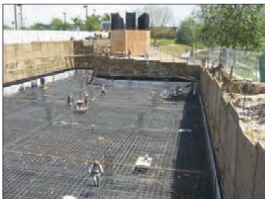
شکل ۳-۶۸ پی بتن مسلح یکپارچه (رادیه ژنرال)
