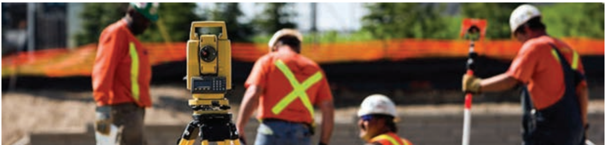
شکل ۴-۱. پیاده کردن با دوربین نقشه‌برداری
