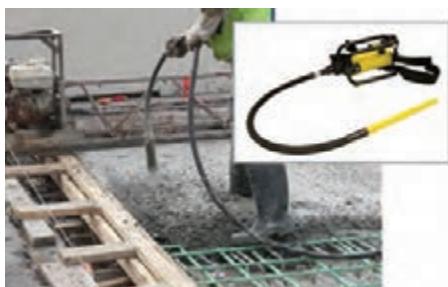
تراکم بتن تازه با دستگاه ویبره
