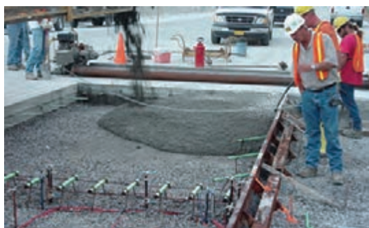
اجرای روسازی بتنی با استفاده از قالب بندی
