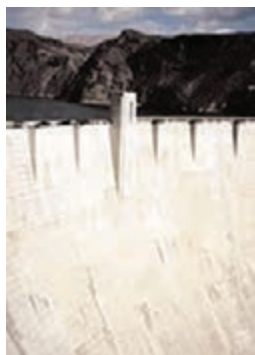
شکل ۴- استفاده از سیمان نوع ۴ در سد سازی
