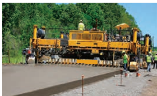
اجرای روسازی بتنی با استفاده از دستگاه
