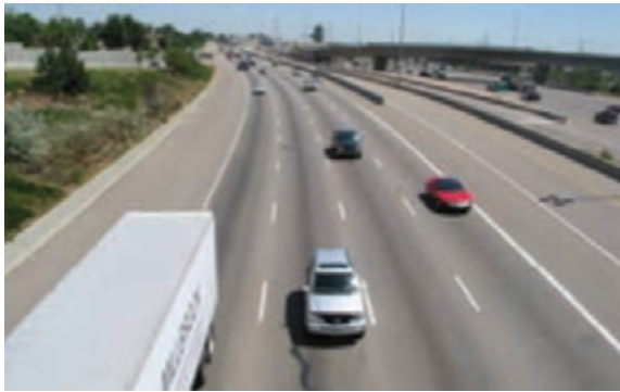
شکل ۸- سطح خدمت دهی A
