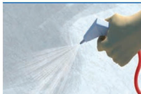
پاشیدن مواد نگهدارنده رطوبت بر سطح بتن
