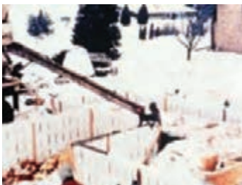
شکل ۳- سیمان‌های زودسخت‌شونده، موارد استفاده (چپ به راست): بتن‌ریزی در هوای سرد، بهره‌برداری سریع از روسازی راه جهت به حداقل رسیدن ترافیک و باز کردن سریع قالب‌ها
