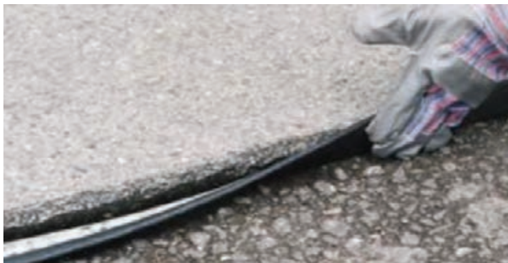
شکل ۴۸- نصب نوار لکه‌گیری بر روی دیواره آسفالت
