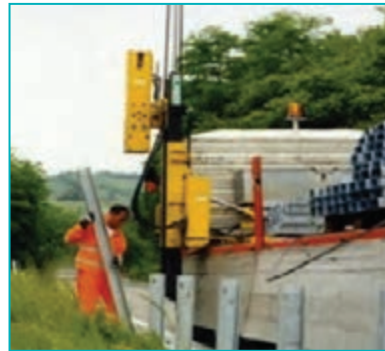
شکل ۳۴- چکش هیدرولیکی گاردریل کوب
