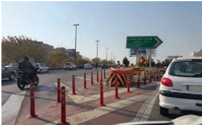
شکل ۱۷-ب) محل قرارگیری ضربه‌گیرهای بشکه‌ای در ناحیه دماغه راه
