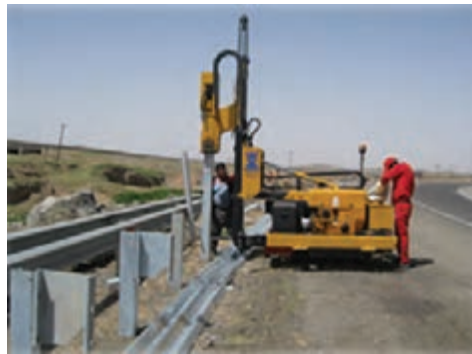
شکل ۴۴- پایه کوبی، نصب لقمه
