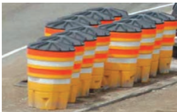
شکل ۲۷- طریقه نصب و چیدمان صحیح ضربه‌گیرهای بشکه‌ای
