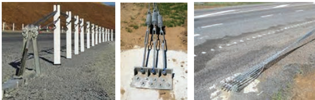
شکل ۲۰- نمونه‌هایی از انواع مهارهای حفاظ کابلی
