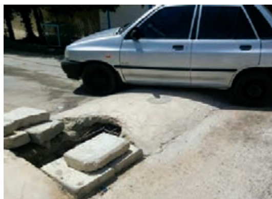
شکل ۹- ساخت سرعت‌گیر غیر استاندارد بتنی و آسفالتی
