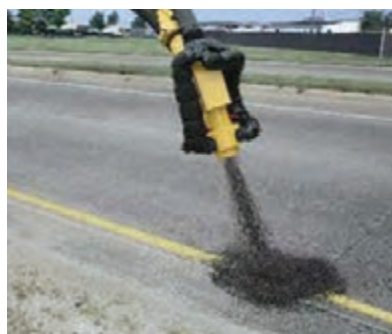
شکل ۴۶ - تزریق با فشار مخلوط قیر و سنگدانه (الف)، پاشیدن پوششی از سنگدانه خشک روی محل ترمیم (ب)
