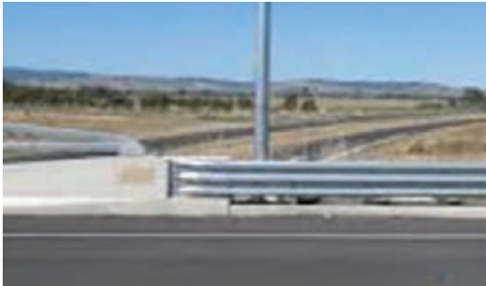
شکل ۸۲ - ناحیه انتقالی حفاظ سه موج به نیوجرسی
