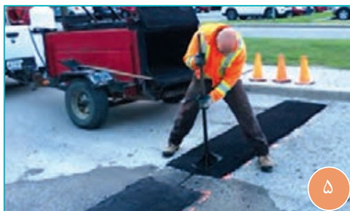
شکل ۷- مراحل اجرای سرعت گیر آسفالتی
