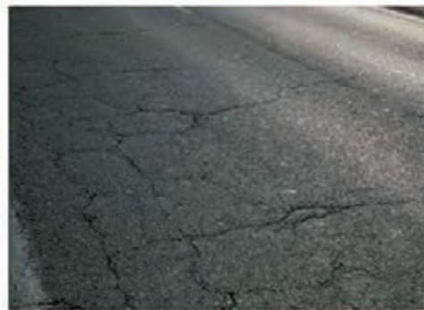
شکل ۳- ترک‌های بلوکی
