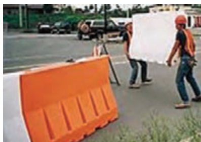
شکل ۳۰- حمل حفاظ پلاستیکی برای نصب در مسیر
