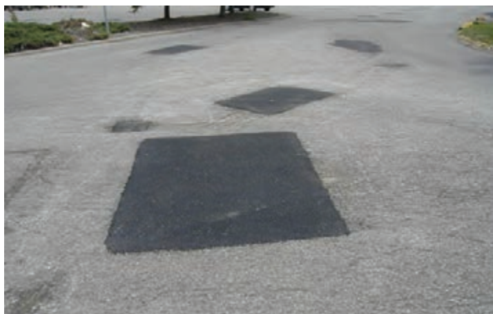
شکل ۹- نمونه‌ای از لکه‌گیری در روسازی آسفالتی
