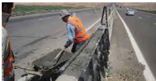
شکل ۲۳- تعمیر حفاظ بتنی (نیوجرسی) در محل
