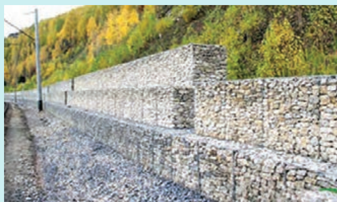
شکل ۱۱- نمایش اجرای پلکانی دیوارهای توری سنگی شده در ترانشه مسیر راه
