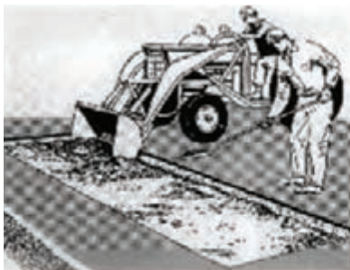
برداشتن لایه های آسفالتی و اساس
