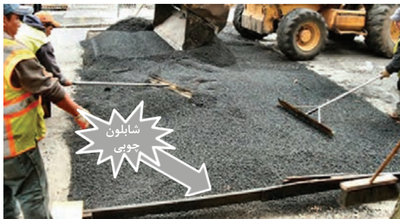
شکل ۲۳- اجرای سرعت‌گاه آسفالتی
