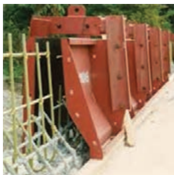
شکل ۴۹- ساخت نیوجرسی (بتن درجا به روش دستی و سنتی)
