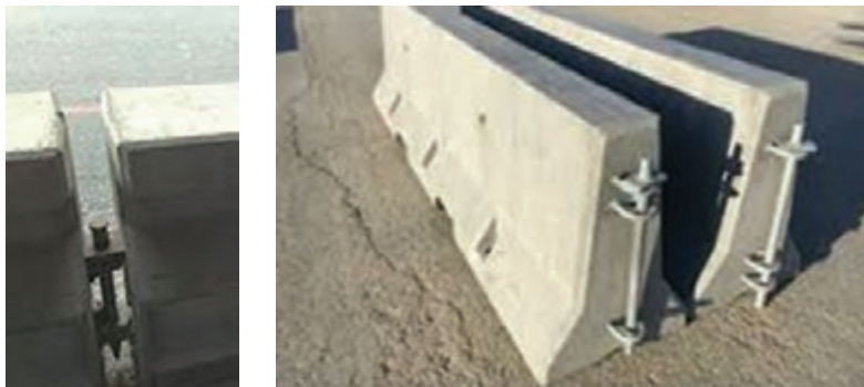
شکل ۵۲- روش اتصال با استفاده از حلقه و بین
