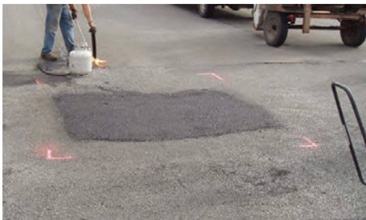
شکل ۳۹- نحوه مشخص کردن محدوده خرابی برای لکه‌گیری
