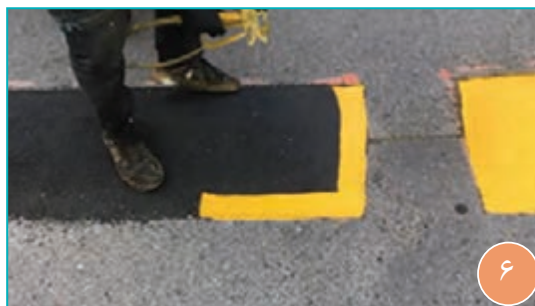
شکل ۷- مراحل اجرای سرعت گیر آسفالتی
