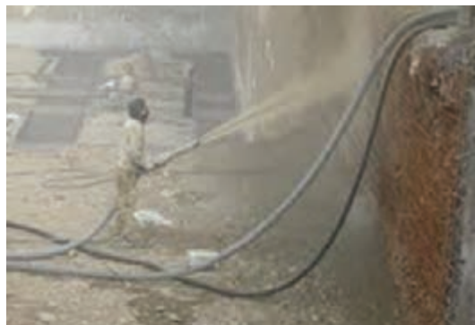
شکل ۲۰- اجرای بتن پاشی (شاتکریت) در بدنه سد
