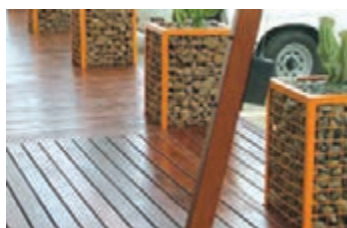
شکل ۷- محوطه‌سازی با اجرای جعبه‌های گابیونی معابر
