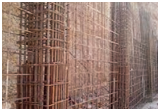
شکل ۲۰- اجرای بتن پاشی (شاتکریت) در بدنه سد
