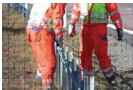
شکل ۶۷- تعمیر حفاظ کابلی
