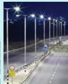
شکل ۷۶- ایمن سازی چراغ برق
