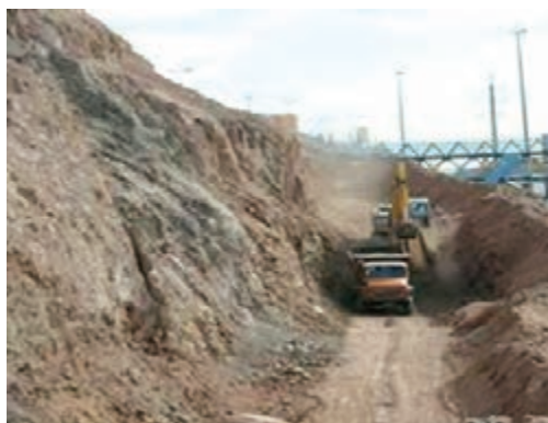
شکل ۱- اجرای عملیات خاک‌برداری
