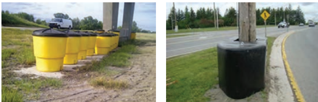
شکل ۲- استفاده از ضربه‌گیرها برای افزایش ایمن‌سازی موانع سخت موجود در حاشیه راه
