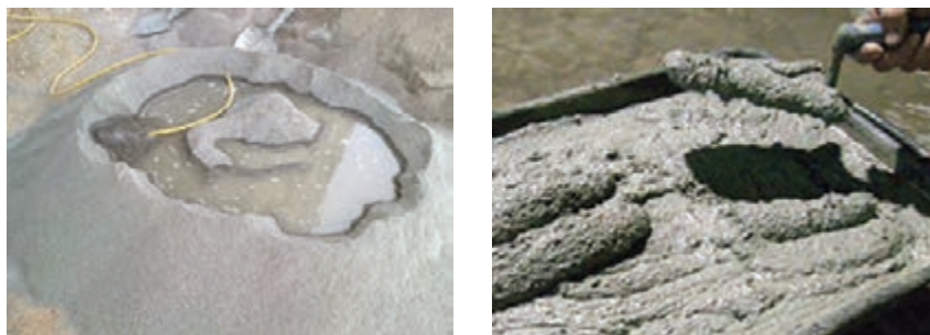
شکل ۱۸- طرز تهیه ملات ماسه سیمان
