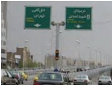
شکل ۲۹ - نمونه‌ای از تابلوهای هدایت مسیر / خروجی (صلیبی)
