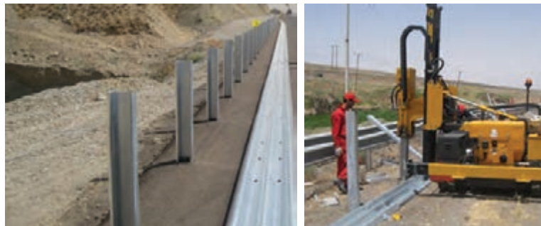
شکل ۴۲- پایه‌کوبی بعد از ریلی کردن سپری‌ها
