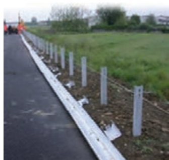
شکل ۴۳- نمونه‌ای از نصب پایه‌های گاردریل با ریسمان‌کشی
