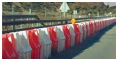
شکل ۲۹- حفاظ پلاستیکی نصب شده در مسیر
