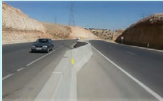
شکل ۵۵- وضعیت نیوجرسی بعد از تصادف با کامیون
