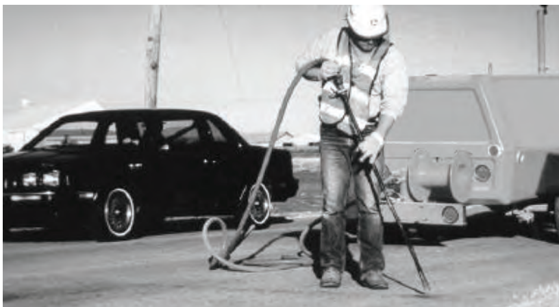
شکل ۲۱- تمیز کردن ترک با فشار بالای هوا با استفاده از کمپرسور هوا
