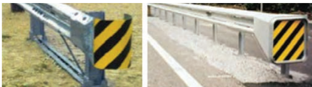
شکل ۷۳- نمونه‌هایی از مهارهای انتهایی و ضربه‌گیر
