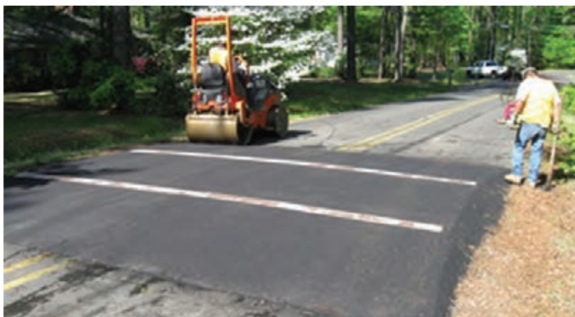
شکل ۲۴- غلتک زدن سطح سرعت‌گاه
