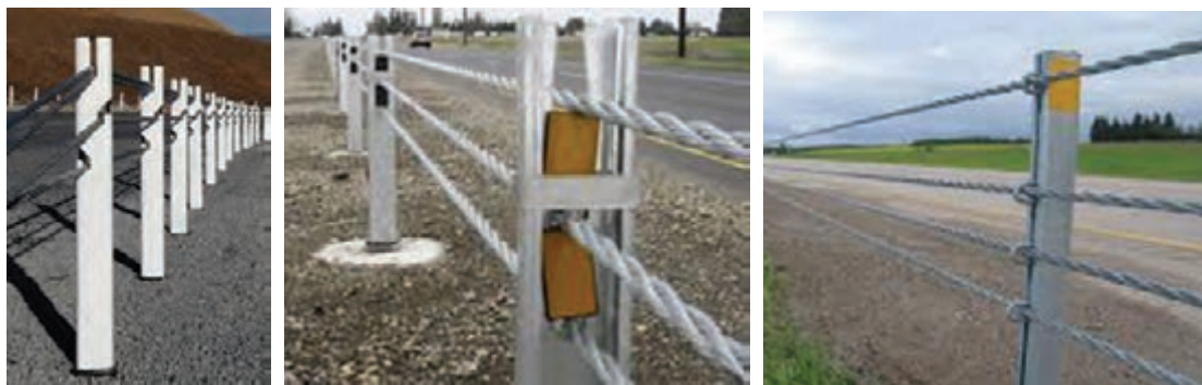
شکل ۱۸- نمونه‌هایی از انواع پایه های حفاظ کابلی
