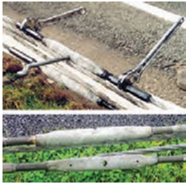
شکل ۴۸ - تنظیم کشش کابل
