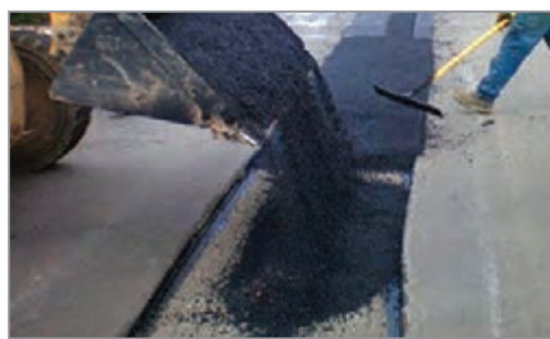
شکل ۴۰- روش ریختن و غلتک زدن
