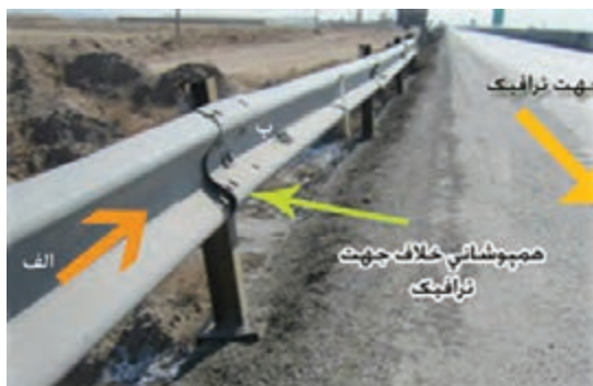
شکل ۴۱- جهت صحیح ریل کردن سپری
