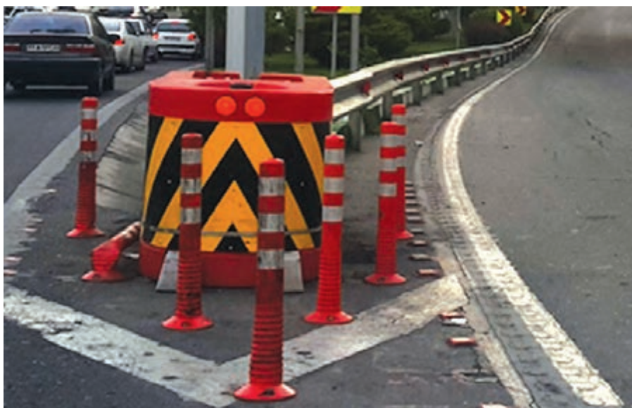
شکل ۲۱ - اجزای ضربه گیر ریلی در تهران
