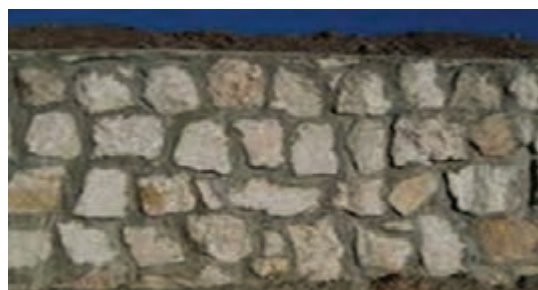
شکل ۱۷- استفاده از ملات در دیوارهای سنگی
