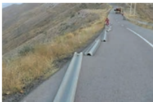
شکل ۳۹- ریل کردن سپری جهت نصب گاردریل (شابلون وجود دارد)
