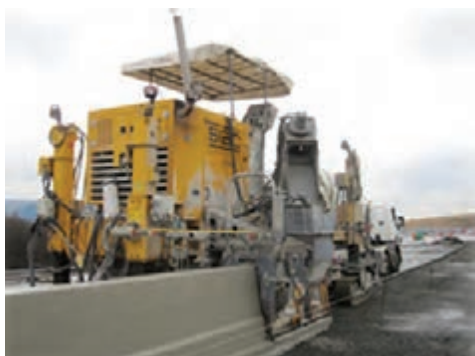
شکل ۵۰- ساخت نیوجرسی (بتن درجا به روش اتوماتیک)
