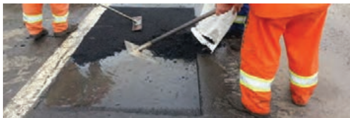
شکل ۳۶- عملیات لکه‌گیری
