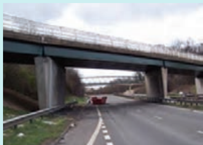
شکل ۷۸- ایمن سازی پایه های پل
