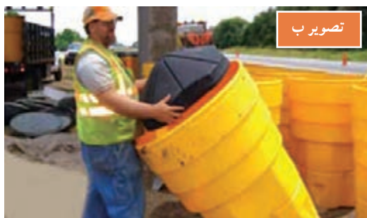
شکل ۲۲- چیدمان بشکه‌ها و قرار دهی مخروط درونی
