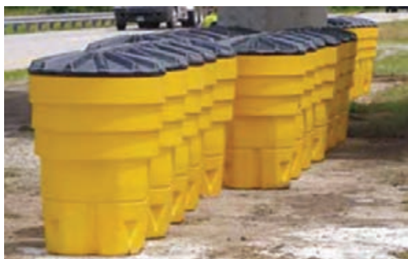
شکل ۲۷- طریقه نصب و چیدمان صحیح ضربه‌گیرهای بشکه‌ای
