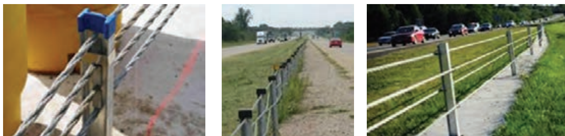
شکل ۴۶- نمونه‌هایی از اتصال کابل به پایه‌ها
