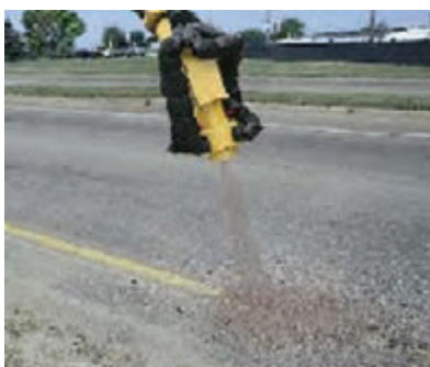
شکل ۴۶ - تزریق با فشار مخلوط قیر و سنگدانه (الف)، پاشیدن پوششی از سنگدانه خشک روی محل ترمیم (ب)
