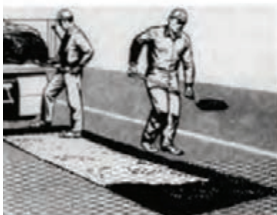
پر کردن محدوده لکه گیری با آسفالت
