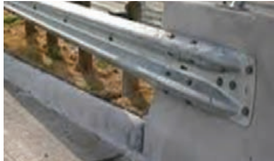
شکل ۸۱ - ناحیه انتقالی حفاظ دو موج به نیوجرسی
