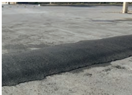
شکل ۹- ساخت سرعت‌گیر غیر استاندارد بتنی و آسفالتی
