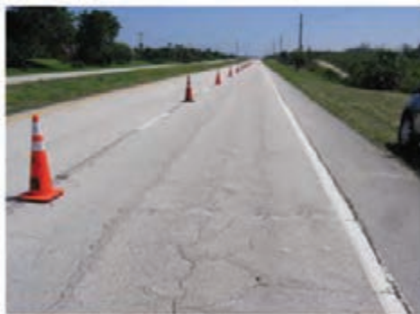
شکل ۳- ترک‌های بلوکی
