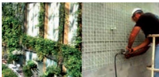
نصب پانل‌ها روی دیوار
