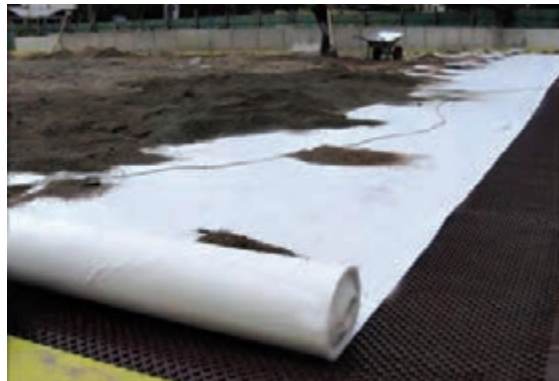
قرارگیری رول ژئوتکستایل در زیر بستر رشد
