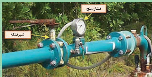
شکل ۱۳- محل شیرفلکه و فشارسنج روی لوله رانش
