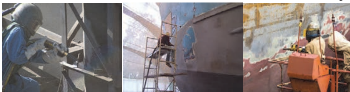
شکل ۱-۷ زنگ‌زدایی در اسکله خشک
