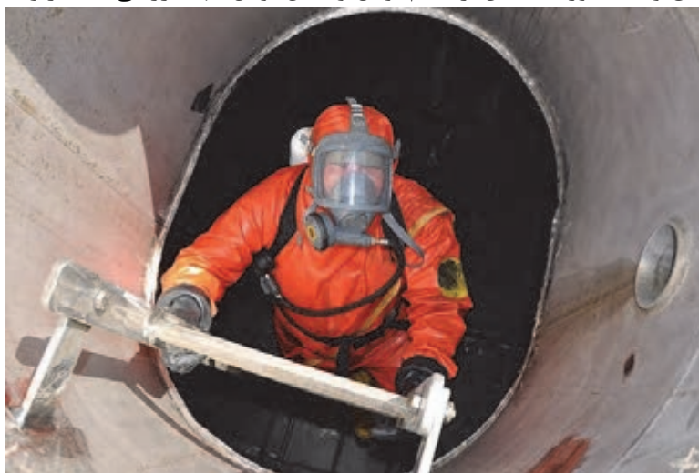
شکل ۱-۳- تعمیرات دوره‌ای مخازن
