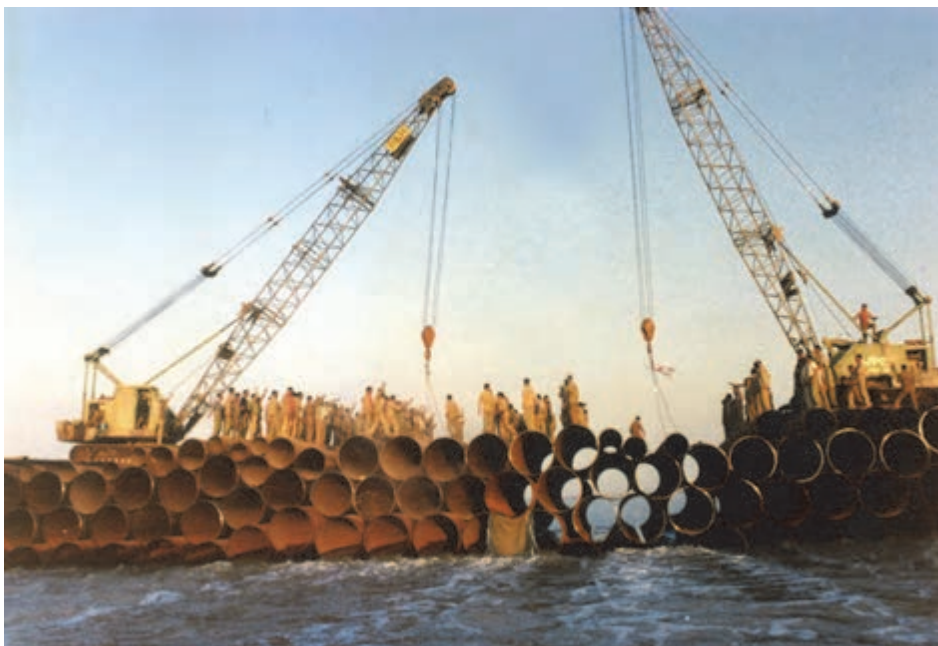
شکل ۱۱-۵- پل بعثت در حال ساخت
