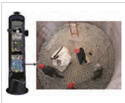
شکل ۷- داخل یک برج در حال چیدن پکینگ‌های سرامیکی
