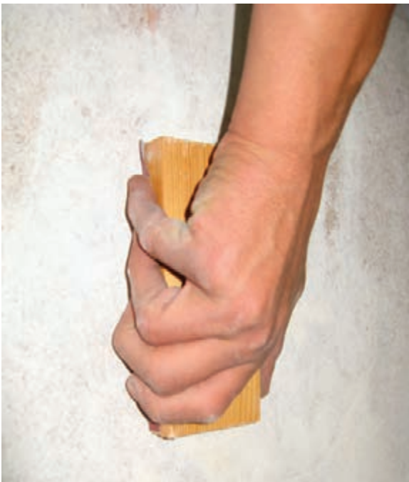
شکل ۱۹-۱۱- سنباده‌کاری سطوح ماستیک‌کاری شده.
