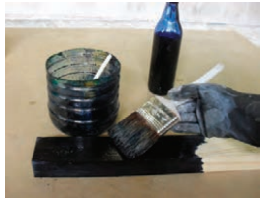
شکل ۵۴-۱۲- زدن آستری آب (روی سطح کار).
