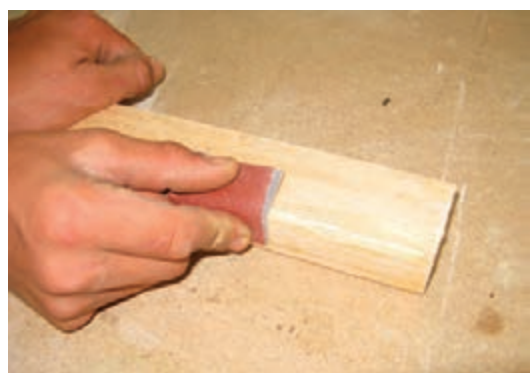
شکل ۱۷-۱۳- سنباده‌کاری روی قسمت افزارخورده لبه چوب نراد.
