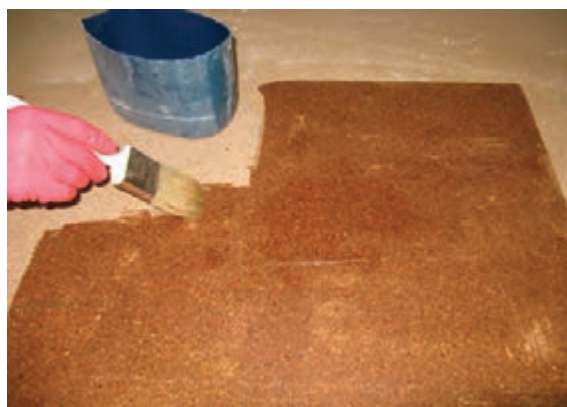
شکل ۴۹-۱۳- روغن اندود کردن سطح کار.
