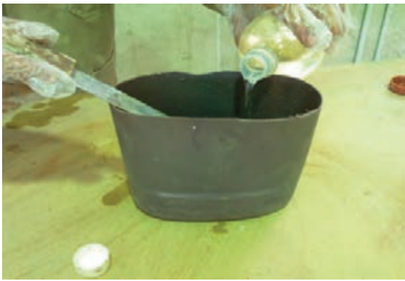
شکل ۶۸-۱۲- رقیق کردن روغن جلا با تینر (روغنی).
