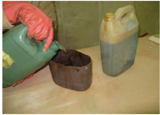
شکل ۸-۱۰- رقیق کردن (روغن الیف با تینر روغنی).
