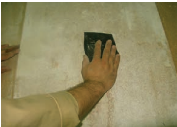
شکل ۴۹-۶- سنباده‌کاری روی سطح بتونه سریشی.
