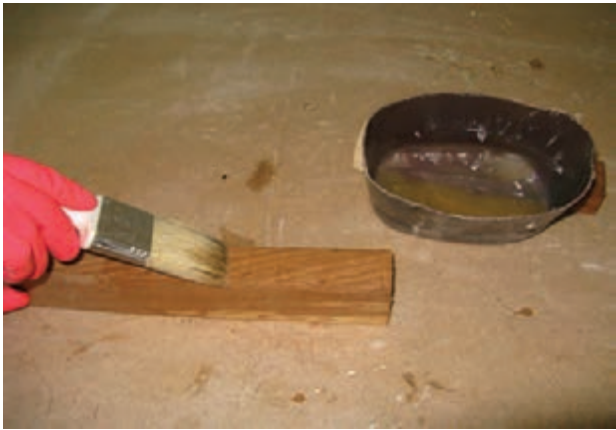
شکل ۳۹-۱۳- زدن سیلر به سطح کار با قلم‌مو.
