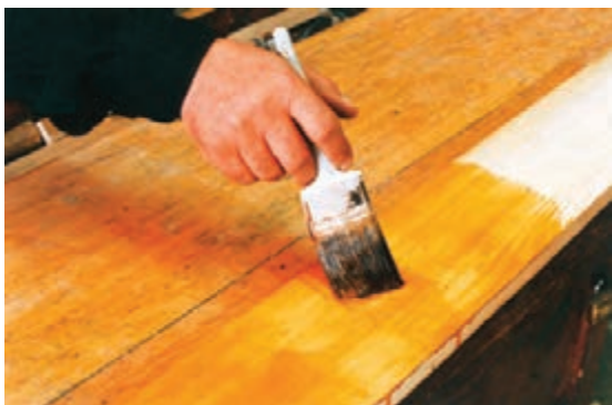
شکل ۳۵-۸- سیلرکاری در جهت فلاف الیاف چوب (جهت بیراه چوب).
