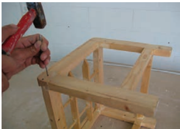
شکل ۸-۱۳- سنبه‌کاری (روی میخ‌ها).
