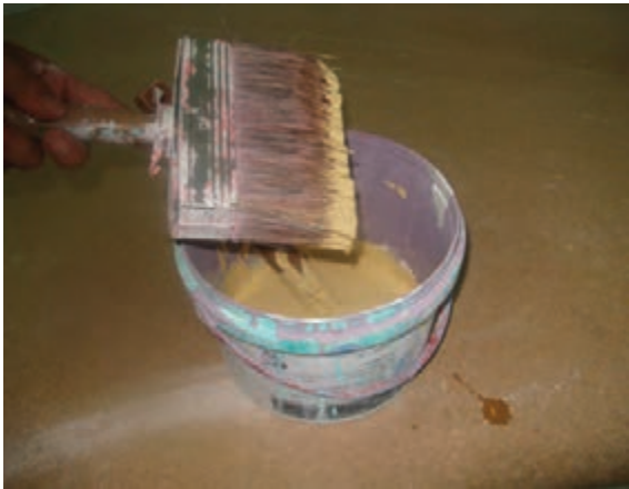
شکل ۵۶-۱۳- رنگ‌کاری دیوار با قلم‌موی ساختمانی.
