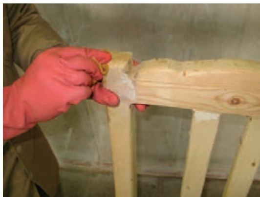
شکل ۳۱۴-۶- بتونه‌کاری غیر پوششی.
