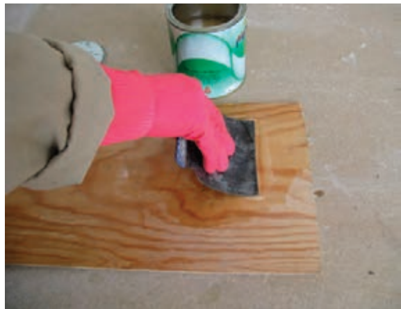
شکل ۵۹-۱۲- استفاده از لیسسه برای زدن سیلر به سطح کار.
