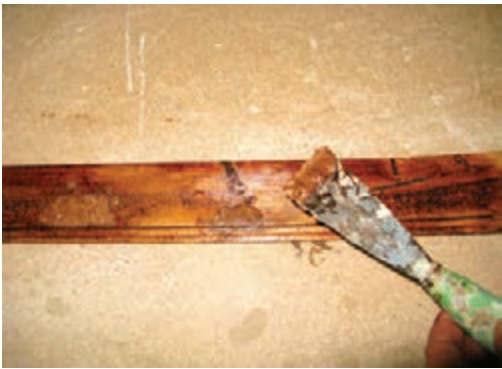
شکل ۱۳-۶- یک تخته آستری‌خورده، بتونه بایستی مطابق با سطح آسترخورده سافته شود.
