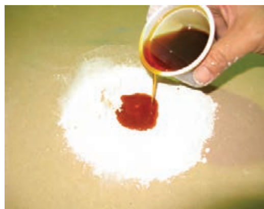
شکل ۲۵-۶- اضافه نمودن رنگ روغنی به بتونه روغنی.
