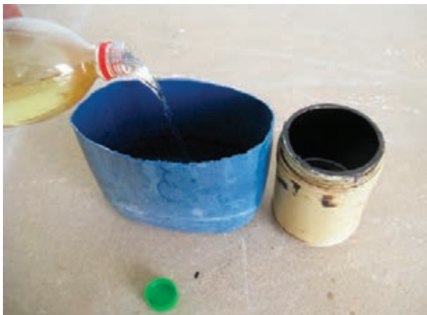
شکل ۴۵-۱۲- اضافه کردن نفت به آستری قیری.
