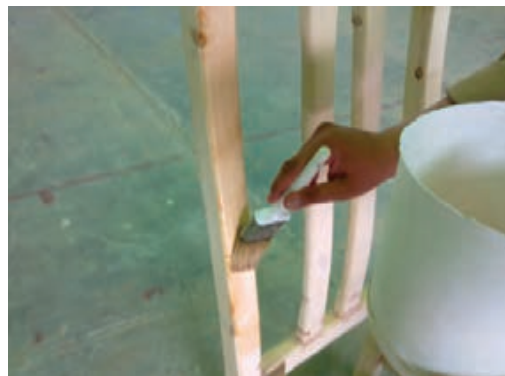
شکل ۳۶-۸- سیلکاری از سمت بالا به سمت پایین.
