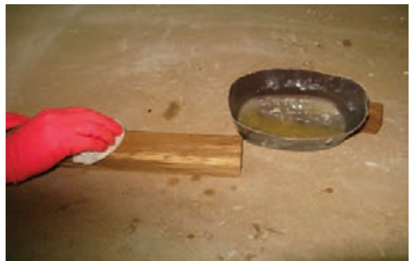
شکل ۳۸-۱۳- سیلرکاری با کهنه رنگ‌کاری.
