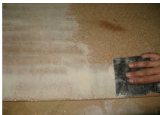
شکل ۳۱۵-۶- بتونه‌کاری نوع پوششی.
