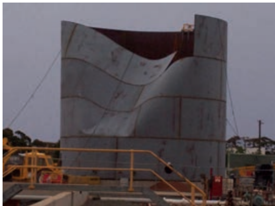
شکل ۴-۲۷- آسیب دیدن مخزن به دلیل وزش باد
