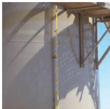
شکل ۲۲-۴- ارتفاع سنج مغناطیسی روی مخزن
