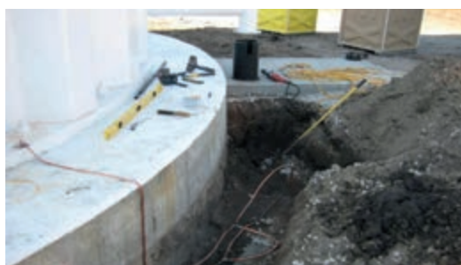
شکل ۴-۲۵- تخلیه الکتریسیته ساکن بدنه مخزن به زمین
