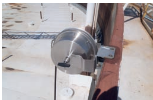
شکل ۴-۲۶- تخلیه الکتریسیته ساکن در مخزن سقف شناور
