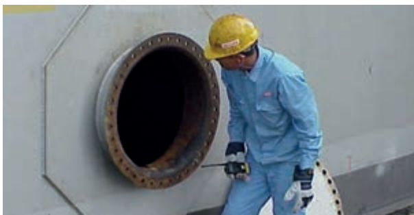
شکل ۲۱-۴- دریچه آدم‌رو مخزن
