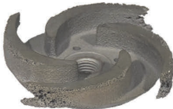
شکل ۳-۱۹- آسیب‌دیدگی پروانه پمپ در اثر پدیده کاویتاسیون
