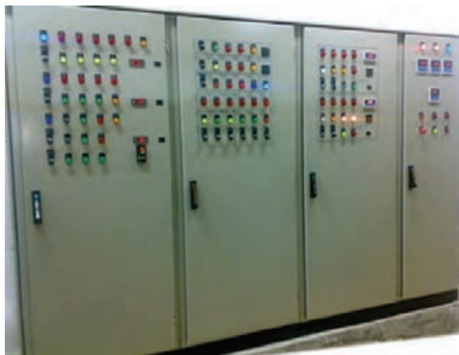
شکل ۱۳- تابلو توزیع برق صنعتی
