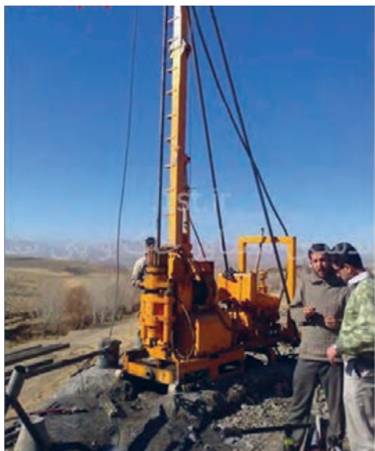
دستگاه حفاری مستقر شده بر روی فونداسیون
