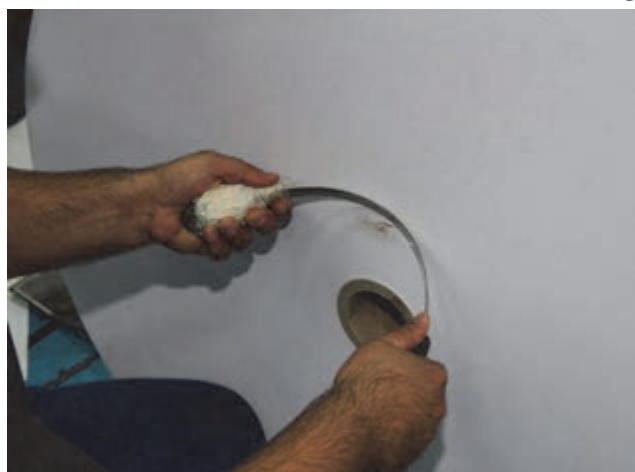
شکل ۵- برطرف کردن آسیب روی بدنه رول
