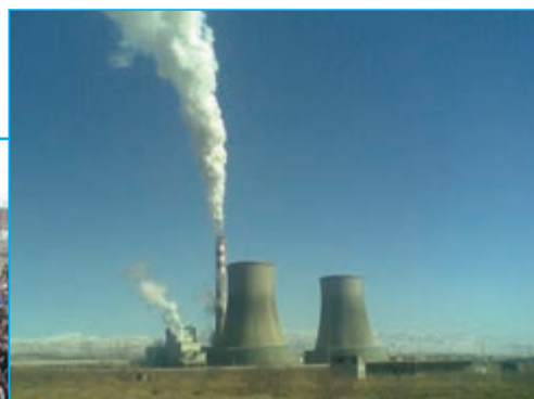
بناب- نیروگاه برق
