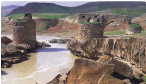
شکل ۲۹-۵- پل گاومیشان دره شهر
