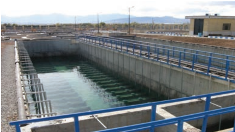
تصویر ۱-۵- تصفیه خانه شهرک صنعتی شهرکرد
