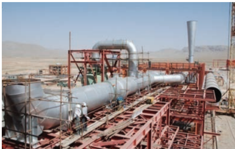
تصویر ۱-۱۵- کارخانه درحال احداث فولاد چهارمحال
