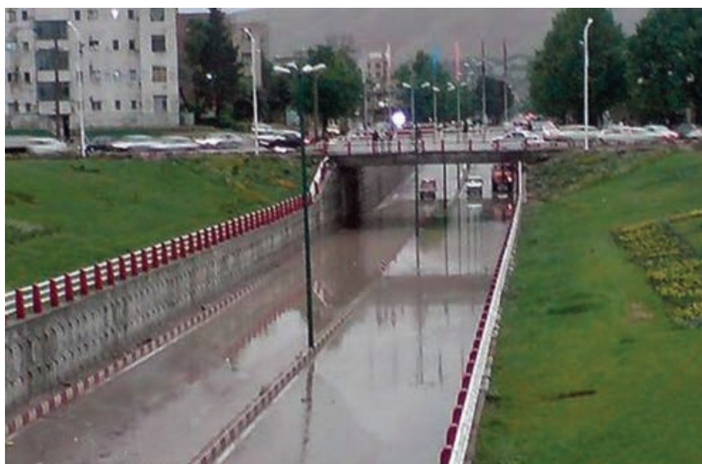
شکل ۱۰-۱۴- یکی از زیرگذرهای شهر خرم‌آباد
