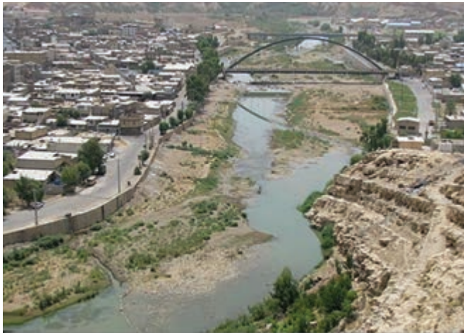
شکل ۷-۵ - خرم‌رود در فصل کم آبی
